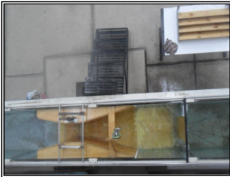
Figura 83. Colocación de la pantalla a 0.75 m antes del aforador, vista en planta.
