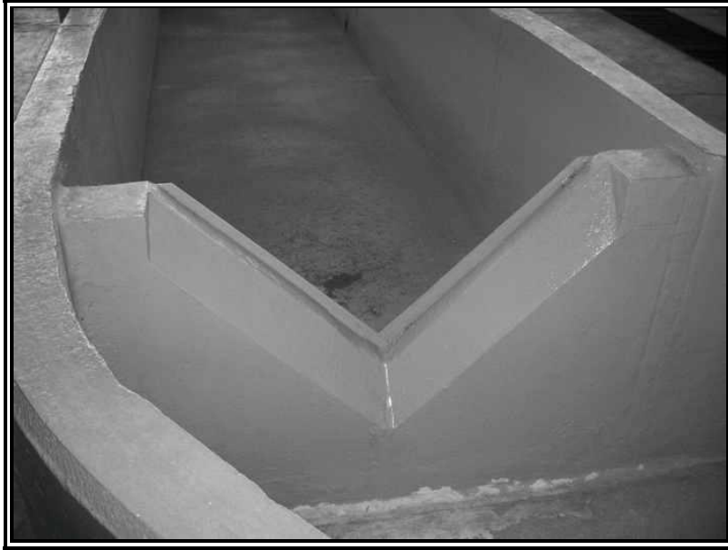
Figura 12. Vertedor triangular.
