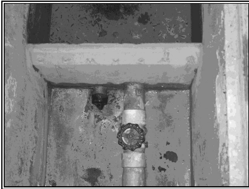
Figura 9. Vertedor Rehbock.
