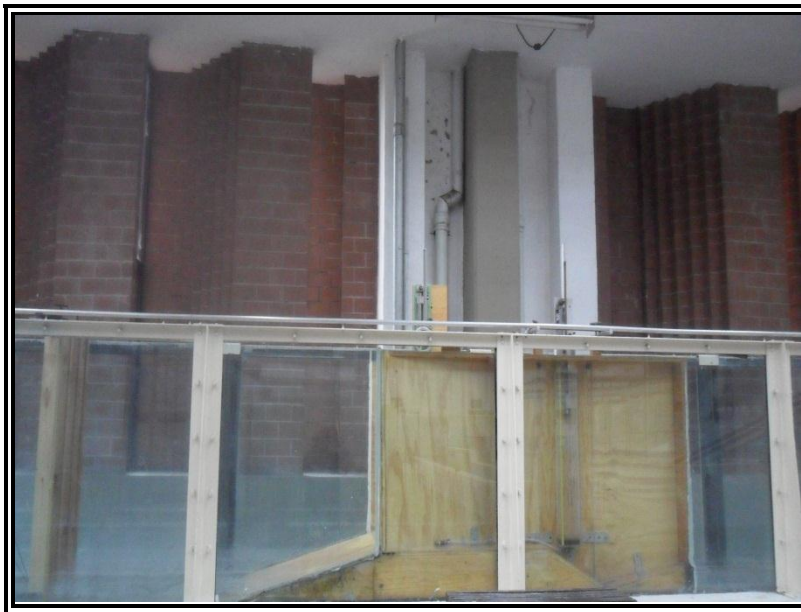
Figura 105. Colocación del desviador a 1.53 m antes del dispositivo, vista de perfil.
