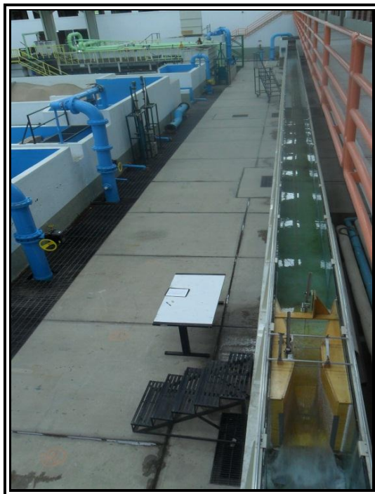
Figura 44. Montaje del aforador Parshall al canal de pendiente constante.
