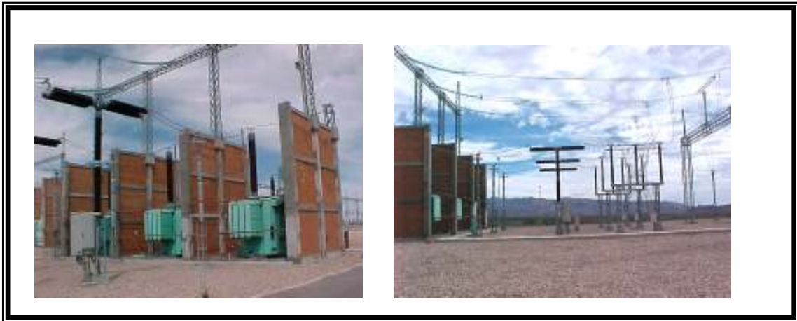
Figura 2-4. Subestaciones con Autotransformadores
