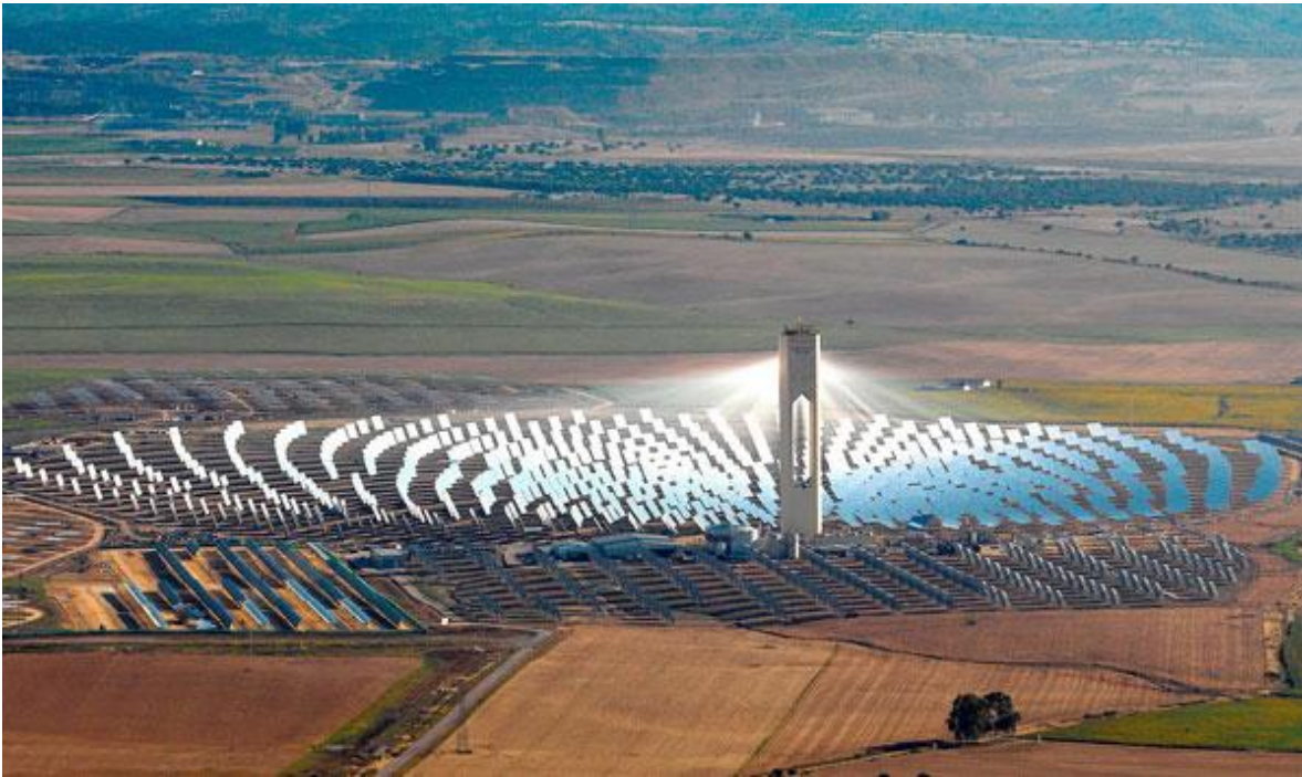
.Figura 26 Planta de torre central PS10 de Abengoa en Sanlúcar Sevilla, con capacidad de 11MW. 50
