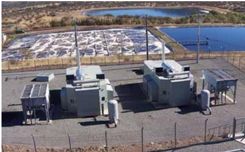
Figura 2. Imagen panorámica de motores de generación eléctrica, Relleno Loma Los Colorados, Chile. Portal de descontaminación Industrial y Recursos Energéticos, (s.f.). Consultado en Octubre de 2010, de: http://www.induambiente.com/ltimas-noticias
