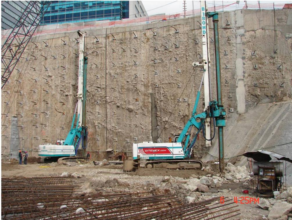
Avenida La Fe, Santa Fe, D.F. Muro Milán con anclas postensadas excavación de 30.0 m
