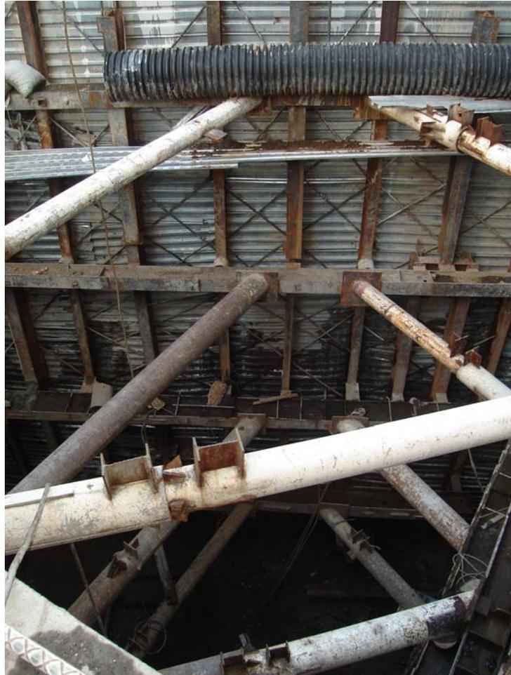
Fig 4.10. Excavación en la zona de Reforma, utilizando un muro Berlín con lámina acanalada losa-acero y 4 niveles de puntales.
