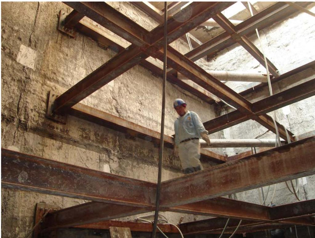
Fig 4.8 Sistema de traves y columnas de los sótanos funcionando como puntales del muro Milán.
