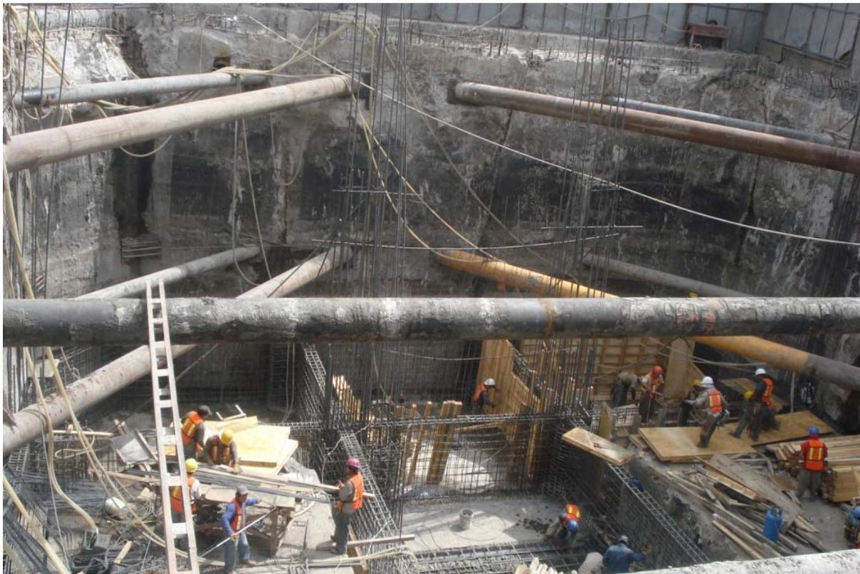
Yosemite e Insurgentes, D.F. Muro Milán con puntales de acero, excavación a 11.0 m.
