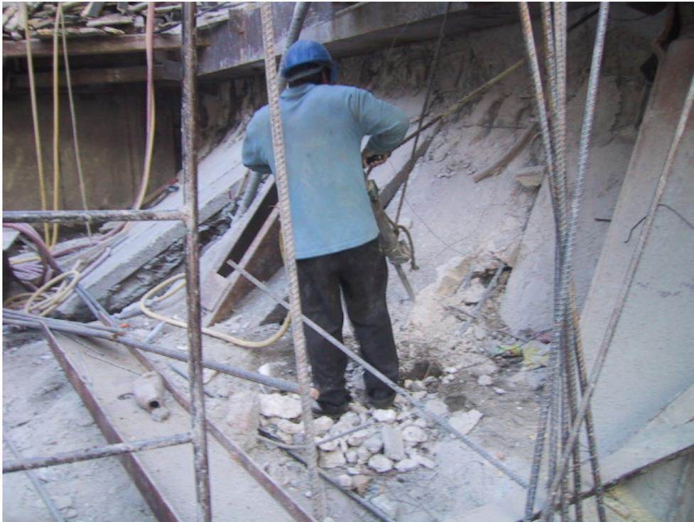
Foto 5.22. Recuperación del nivel en la crujía de la esquina fallada en la que se coló el bloque de concreto de 1,0 m de espesor; se observa la demolición de las tabletas y del concreto masivo. El ataque perimetral se ejecutó en 3 tramos; para continuar con el siguiente se exigió haber concluido la losa y el muro en el anterior.
