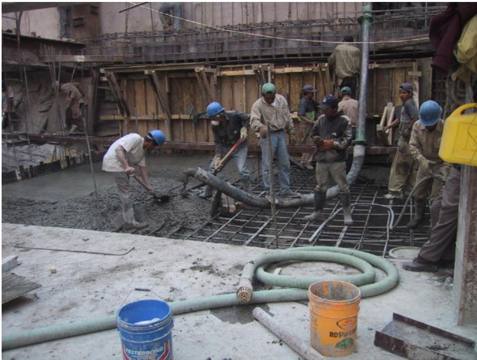
Fig 5.20. Colado del muro perimetral en el entre-eje contiguo al norte de la zona de falla (Fig 5.1), así como el correspondiente a la losa de cimentación.
