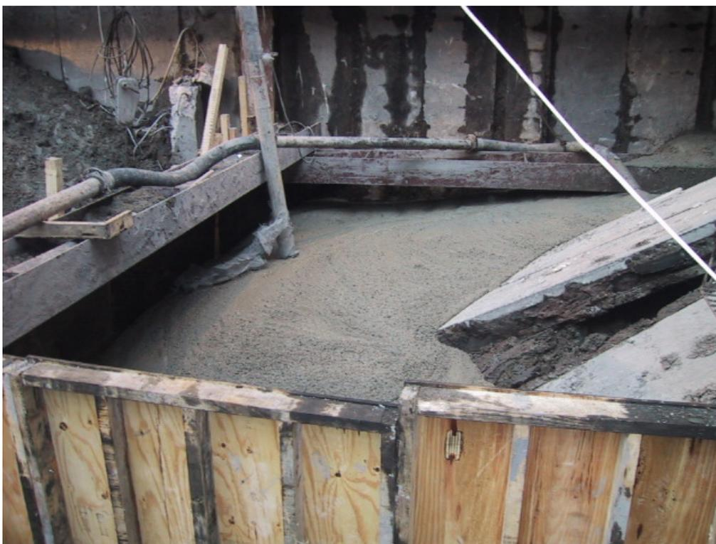
Fig 5.11. Vista en detalle del concreto en la zona de la falla; el lodo del fondo se dejó ahí, al igual que la se dejaron las patas falladas de las tabletas de concreto.
