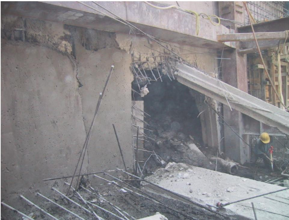
Foto 5.18. Demolición parcial de las tabletas para proceder a la construcción del muro de concreto en la zona del lindero; detrás de ellas se removió el resto del relleno, para después instalar la cimbra para el citado muro y losa de cimentación.
