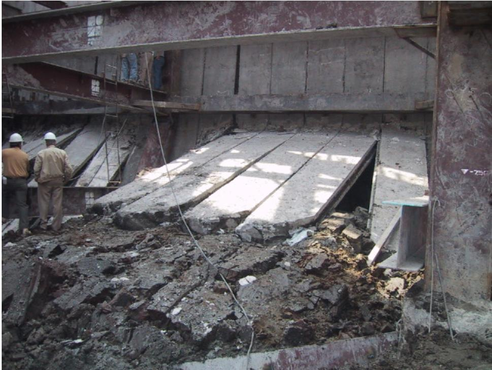
Fig 5.2. Tablaestacas de concreto de 1.0 m de ancho y 0,3 cm de espesor, desplantada a 13,5 m de profundidad; al centro se observan los pies de las tabletas prefabricadas de concreto reforzado; se aprecian también las columnas y traveses de los sótanos que constituyen el sistema de retención.
