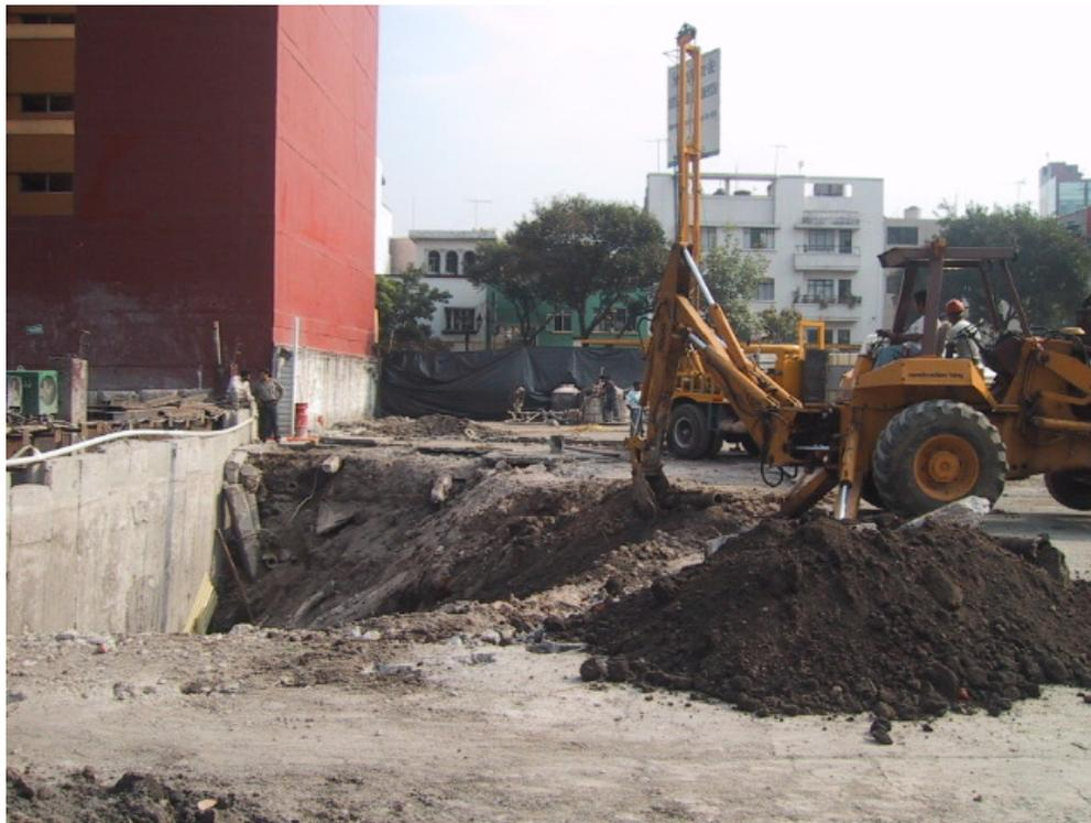
Foto 5.16. Terminada la pantalla impermeable alrededor de la traza de falla, se comenzó con el retiro del material suelto, restos del firme de concreto y restos de las cimentaciones de construcciones antiguas; después se afinó la superficie y se protegió con una cubierta de concreto lanzado de 7 cm de espesor de  $150 \text{ kg/cm}^2$ , reforzado con una malla electrosoldada 6x6-6/6.
