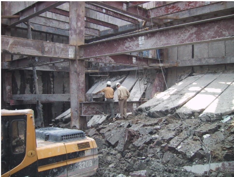
Fig 5.3. Vista general de la falla que involucró 2 crujeías. A la izquierda se observa la colindancia sur, integrada por un edificio de 8 niveles cimentado en una losa complementada con pilotes de fricción; en esta colindancia los desplazamientos horizontales asociados alcanzaron 6,1 cm.
