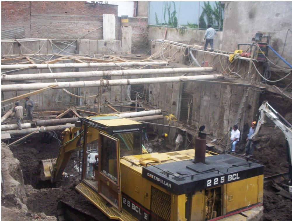
Arquímedes No. 25, Polanco, D.F. Muro prefabricado con 2 niveles de puntales para una excavación de 10.0 m de profundidad.
