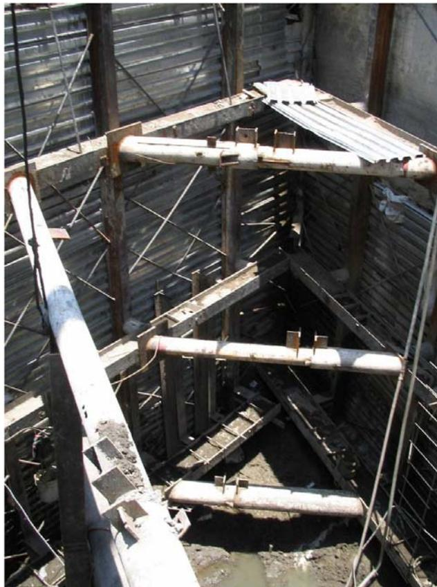
Reforma y Berna, D.F. Muro Berlín con puntales, excavación a 13.0 m.
