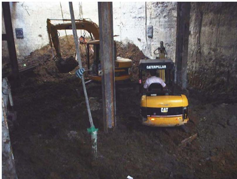
Fig 4.7 Mini-retroexcavadoras realizando la excavación
