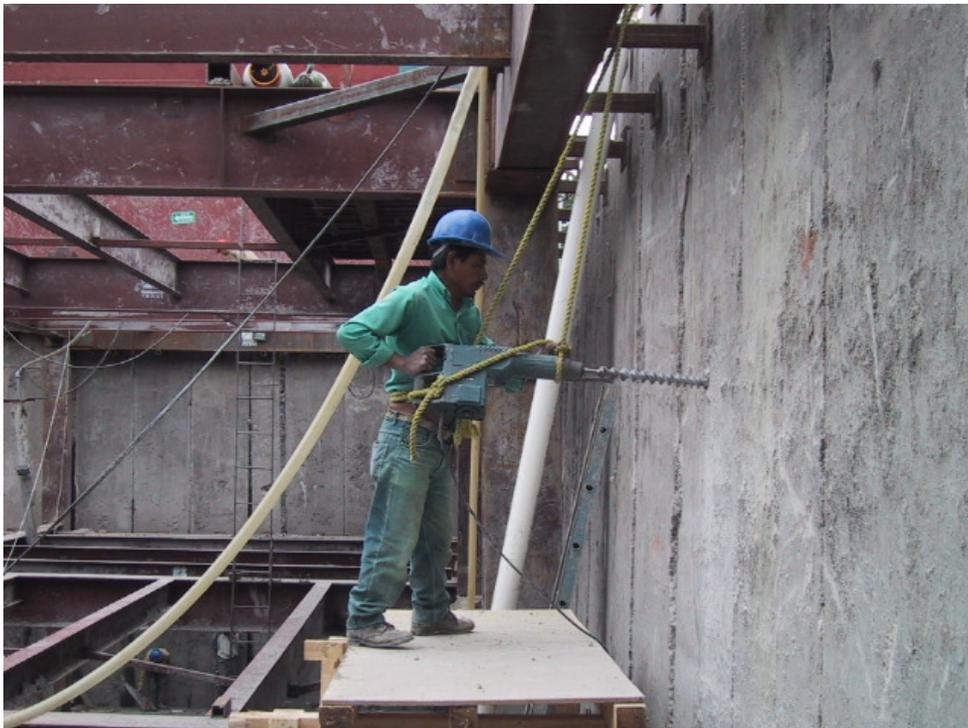
Fig 5.14. Perforaciones en las tabletas para drenar la zona fallada, y controlar el agua con el bombeo interior de la excavación.
