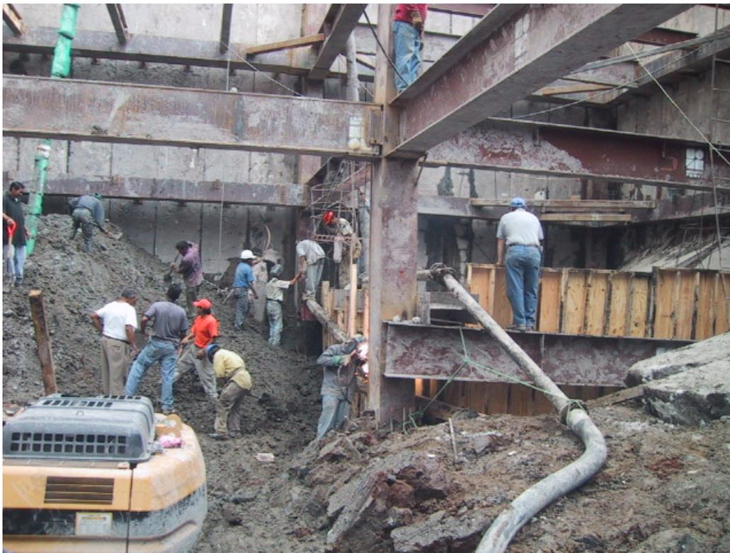
Fig 5.10. Colado de bloque de concreto de 1,0 m de espesor para estabilizar la zona de la falla y garantizar la estabilidad del edificio de 8 pisos; se aprecia claramente la tubería de concreto y la cimbra; ello se realizó en la crujía de la esquina surponiente (Fig 5.1).
