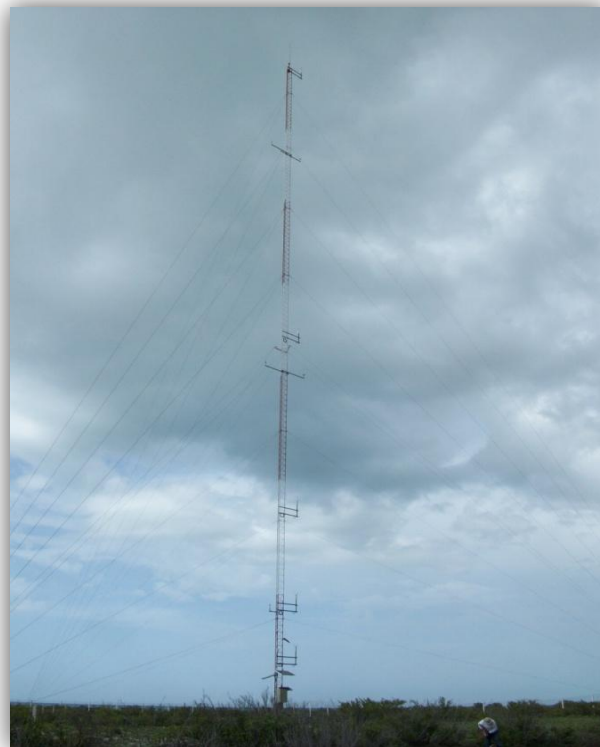
Figura 3.2-2 Torre meteorológica de 50 metros en Sisal, Yucatán.
