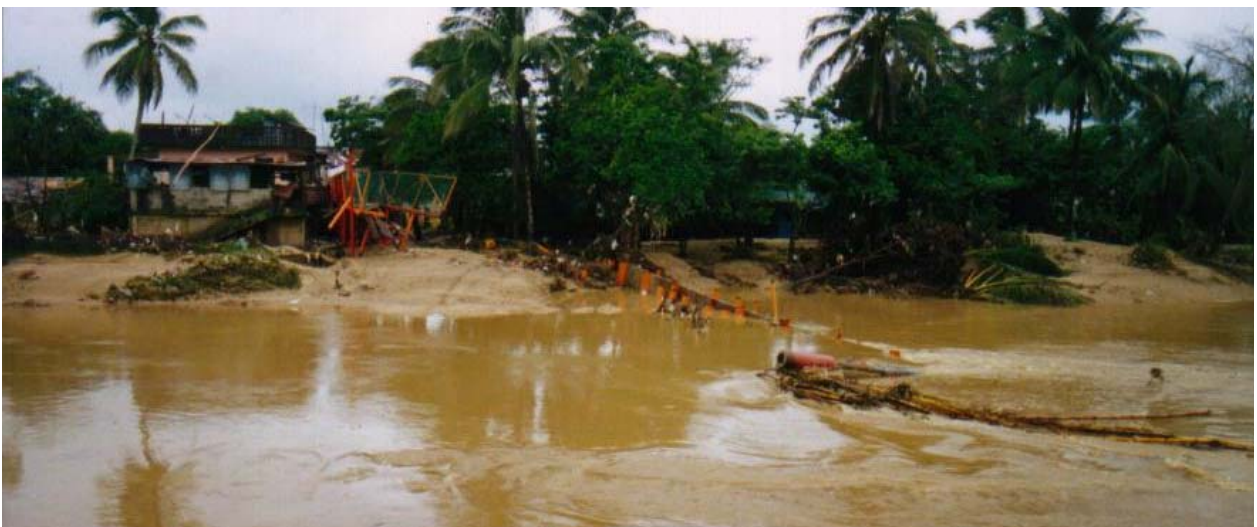
Figura 3.13 Puente destruido. Obstrucciones en el cauce
