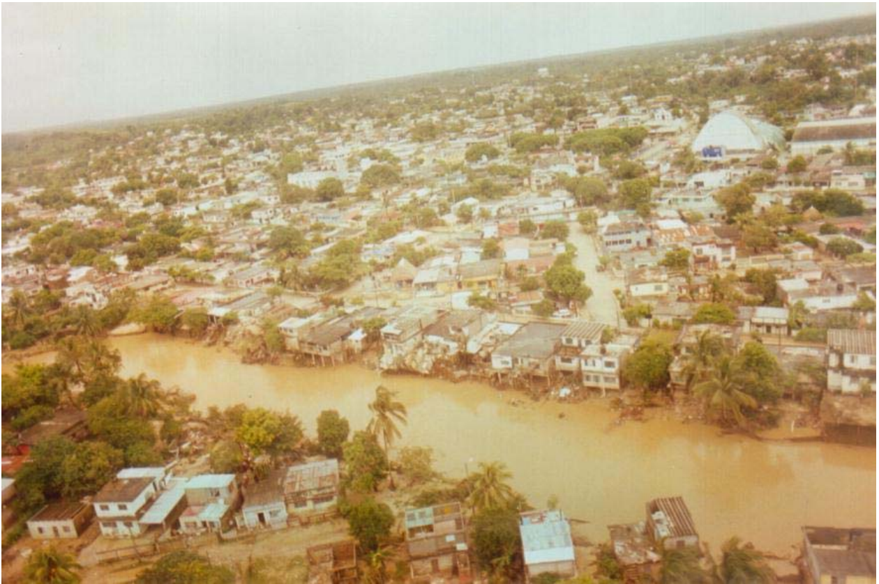
Figura 3.10 Vista del arroyo Agua Dulce en el tramo aguas abajo, obstrucciones en la margen izquierda e invasión del cauce por construcciones urbanas
