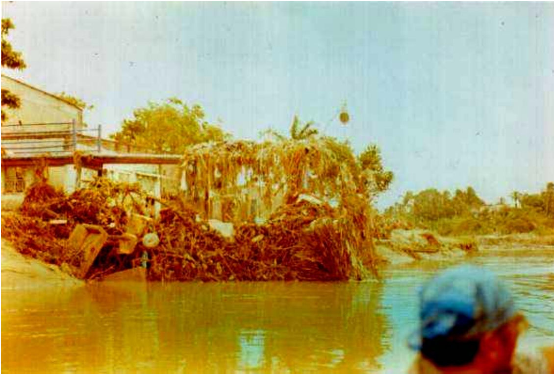
Figura 4.3 Destrucción de puente sobre el arroyo Agua Dulce
