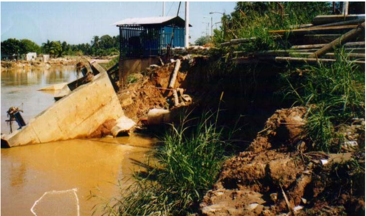
Figura 3.4 Vista de la constitución de material del cauce del arroyo Agua Dulce, tramo aguas abajo
