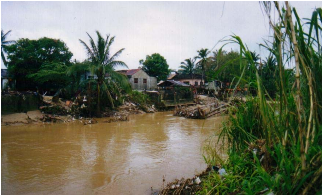
Figura 3.8 Vista del cauce del arroyo Agua Dulce, tramo aguas abajo, obstrucciones en la margen derecha
