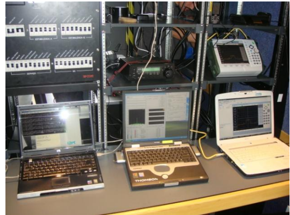
Figura 3.12. Equipos de medidas en la unidad móvil.
