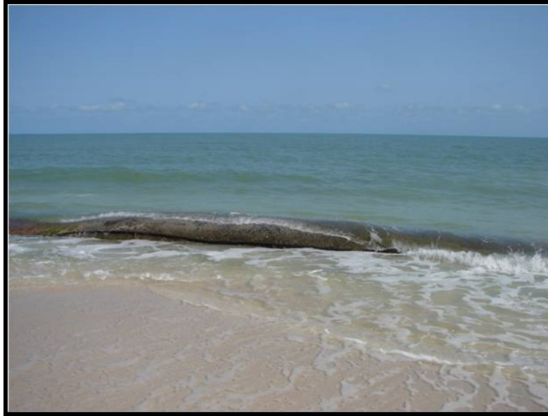
Figura 1-5 Muestra de geotextil instalado en la zona de estudio para contribuir a la acumulación de sedimentos
