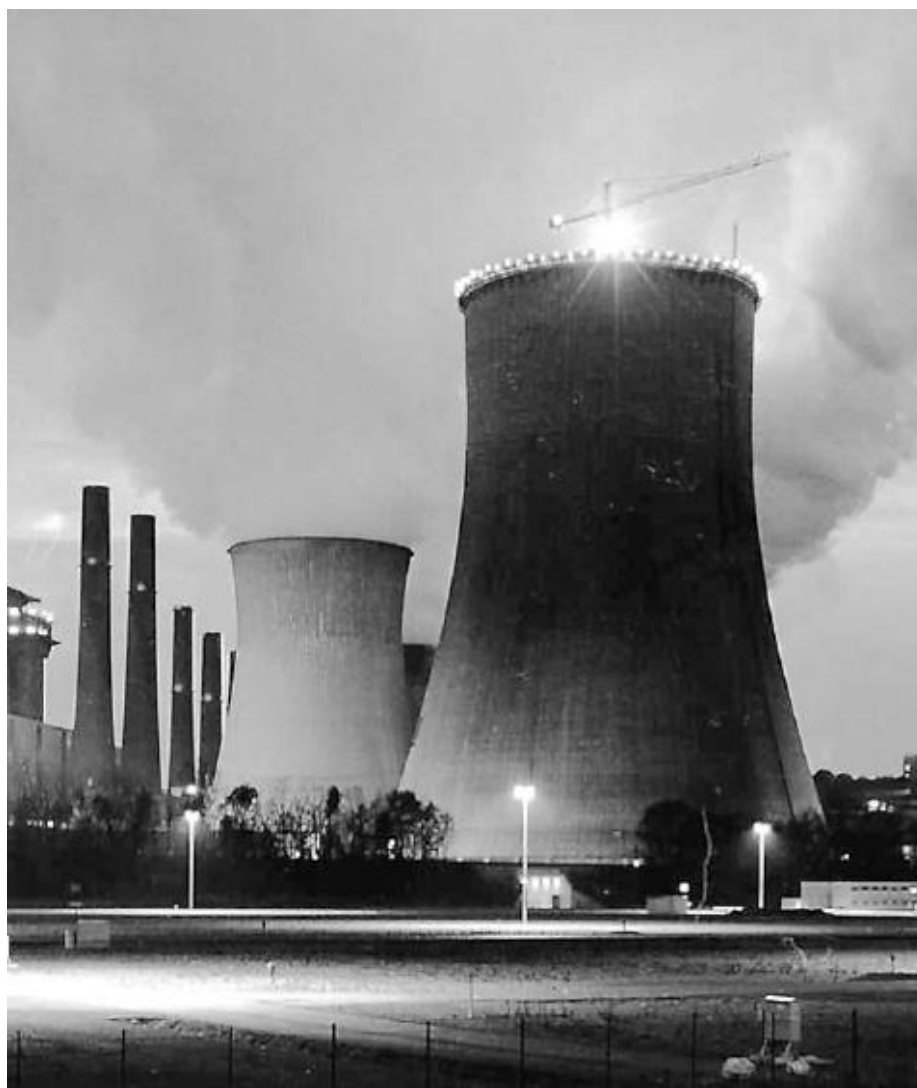
Fig 1 Torre más alta del mundo, en construcción con 200 m de altura. Enero de 2000
