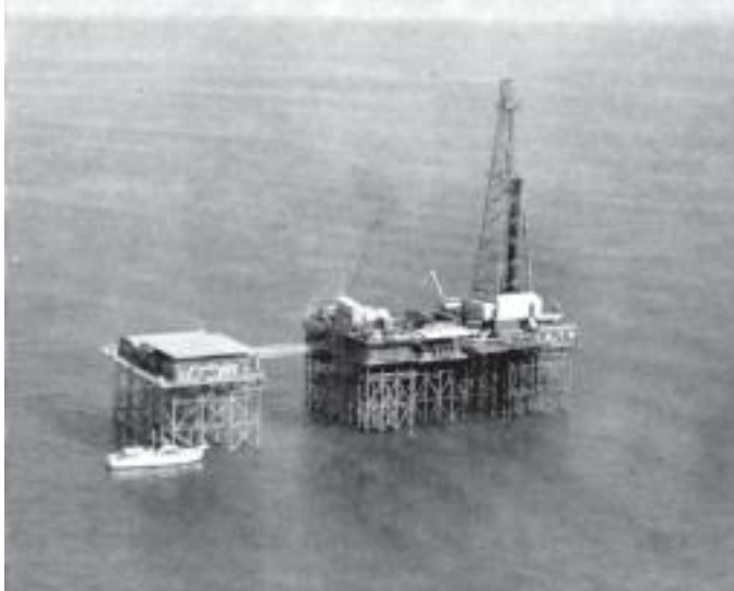
Fig. 1.3 Plataforma en Vermilion Block 71 en el Golfo de México, de la Superior Oil Company en 1947.
