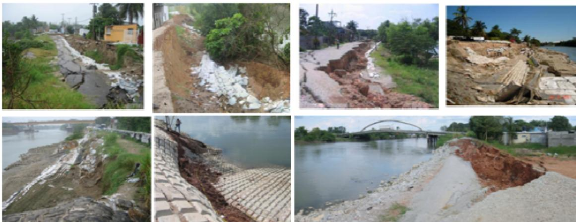
Figura 6.15 Evidencias de inestabilidad en las márgenes de los ríos debidas a fallas por cortante favorecidas por el fenómeno del vaciado rápido (Auvinet & López-Acosta, 2009).
