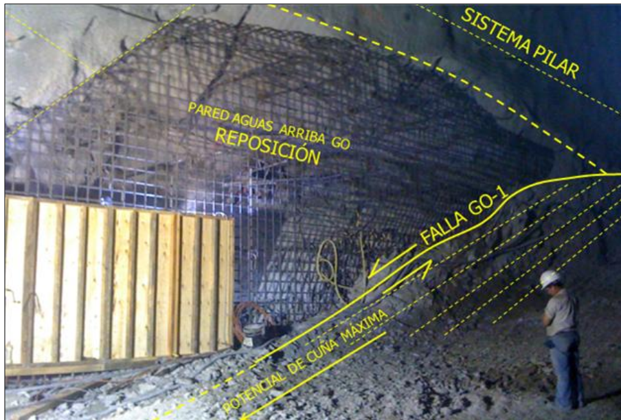
Figura 2.110.- Trabajos para realizar la reposición en la pared de aguas arriba.
