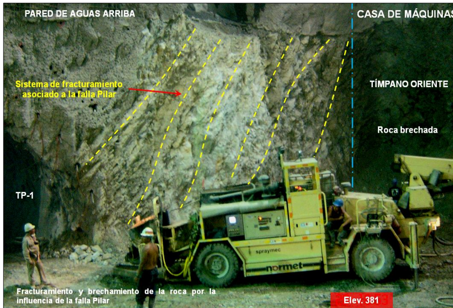
Figura 2.70.- Fracturamiento en la pared de aguas arriba de casa de máquinas.
