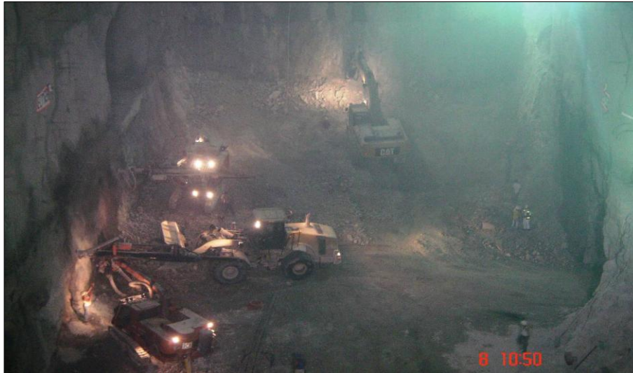
Figura 2.52.- Equipo utilizado en el proceso de excavación de banqueros y fosos de turbina.
