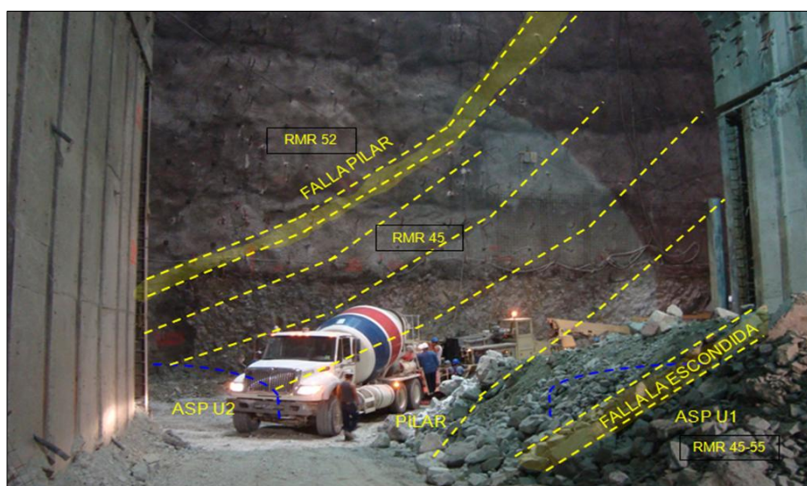
Figura 2.120.- Replicas entre las fallas Pilar y Escondida.
