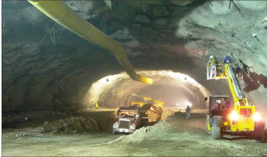
Figura 2.54.- Equipo y maniobras en el proceso de retiro del material producto de la excavación en la caverna de casa de máquinas.
