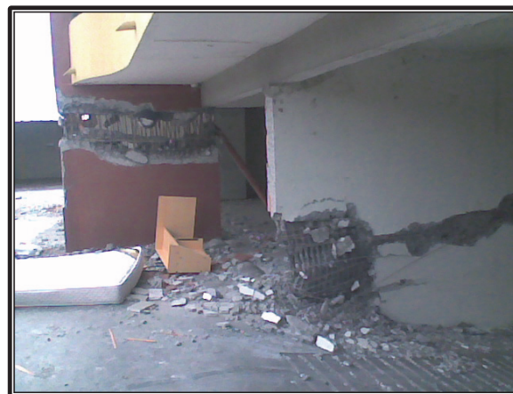
Figura 3.42: Edificio Centro Mayor, Concepción, Chile. (Ref. IV)
