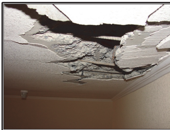
Figura 3.47: Edificio Don Manuel, Macul, Santiago, Chile.
