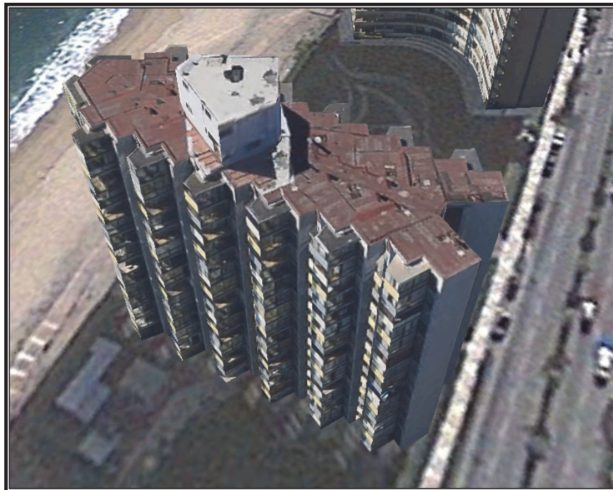
Figura 2.51: Edificio Acapulco, Viña del Mar, Chile.
