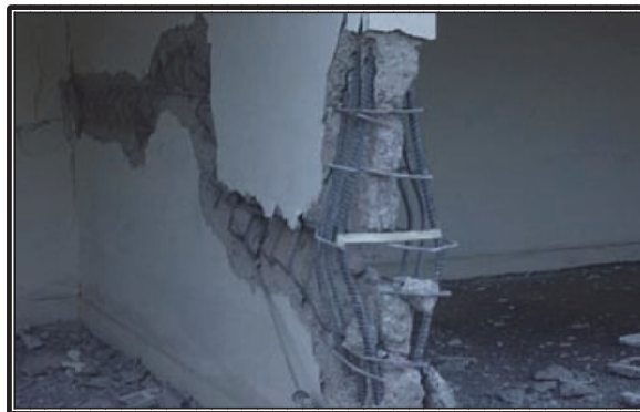
Figura 3.39: Edificio Regina Oriente, Ñuñoa, Santiago, Chile.
