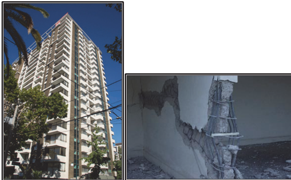
Figuras 3.36 y 3.37: Edificio Regina Oriente, Ñuñoa, Santiago, Chile.
