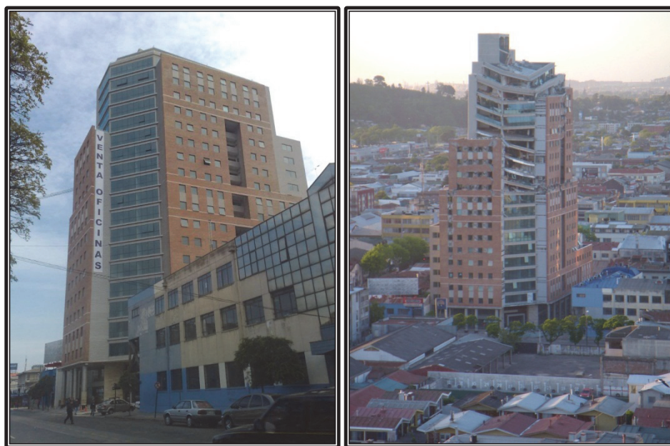
Figuras 3.32 y 3.33: Edificio Torre O'Higgins (antes y después del terremoto de 2010), Concepción, Chile. (Ref. IV)
