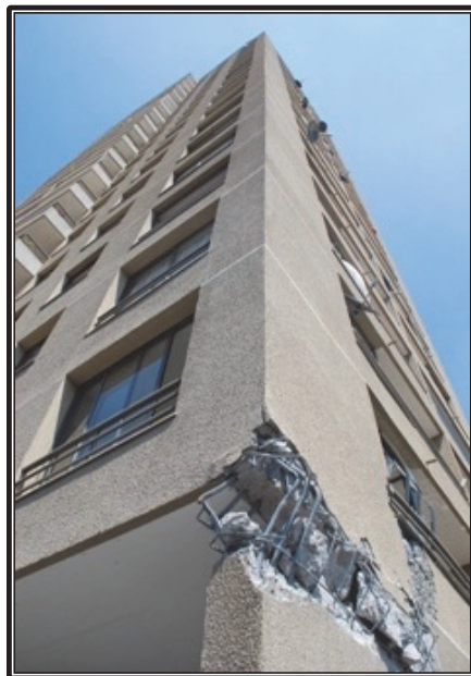
Figura 3.43 Edificio Vista Hipódromo, Santiago, Chile.
