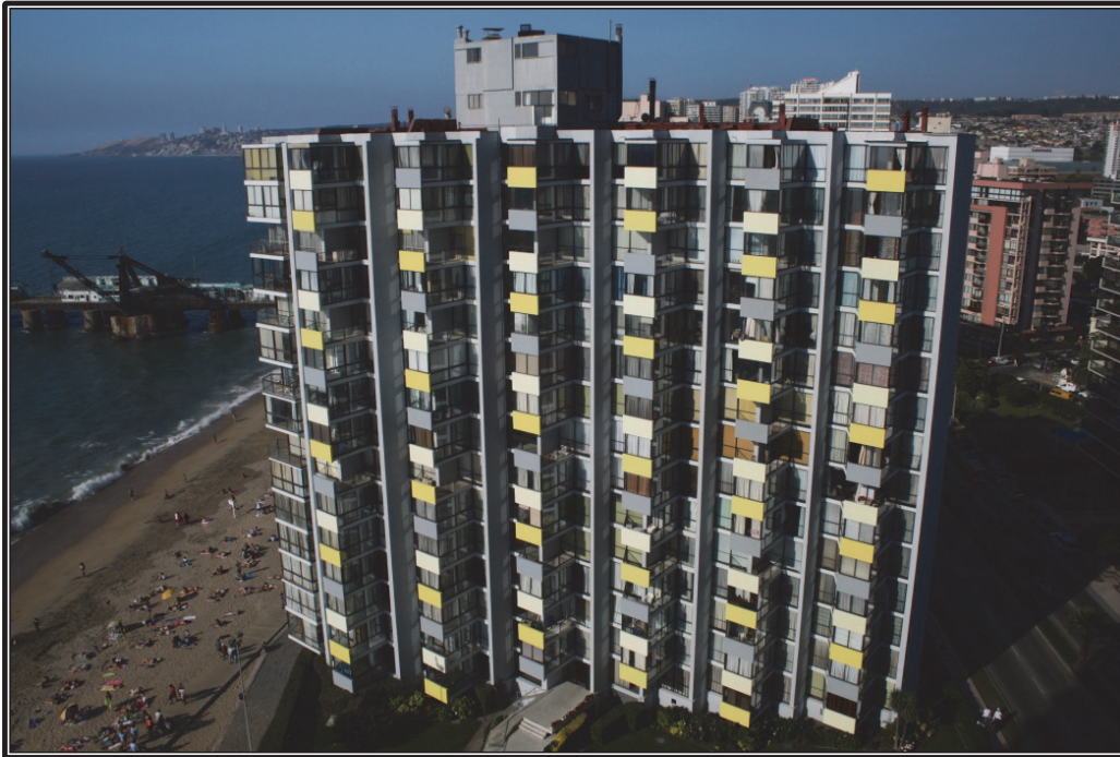
Figura 2.50: Edificio Acapulco, Viña del Mar, Chile. (Ref. I)
