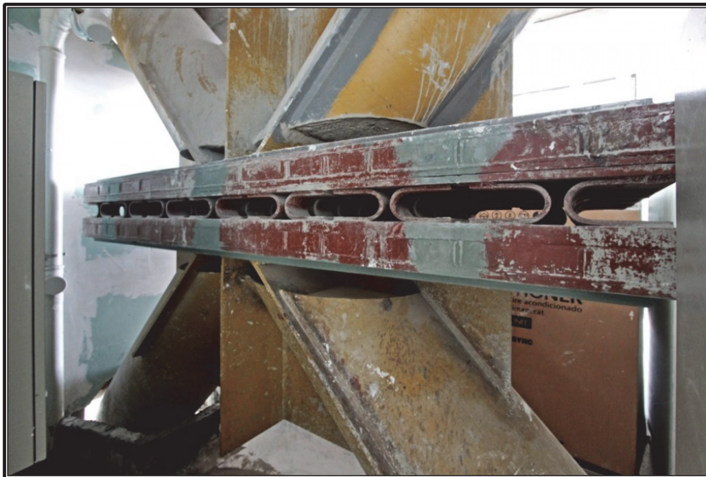
Figura 2.90: Amortiguadores sísmicos de la Torre Titanium La Portada, Santiago, Chile. (Ref. XI)
