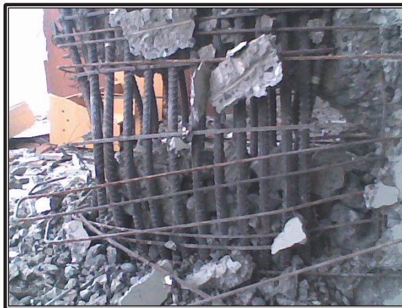
Figura 3.41: Edificio Centro Mayor, Concepción, Chile. (Ref. IV)
