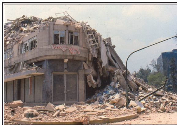
Figura 3.20: Edificio ubicado en Av. Insurgentes y Av. Álvaro Obregón, después de terremoto del 19 de septiembre de 1985, México, DF. (Ref. VI)
