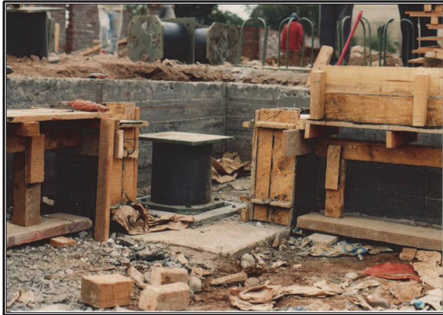
Figura 2.79: Amortiguador de goma de alto amortiguamiento. (Ref. ii)
