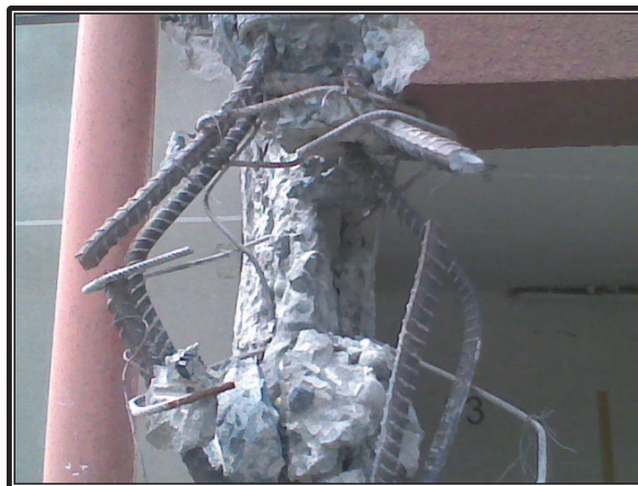
Figura 3.44: Edificio Centro Mayor, Concepción, Chile. (Ref. IV)
