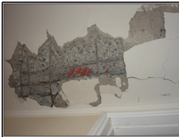
Figura 3.48: Edificio Don Manuel, Macul, Santiago, Chile.
