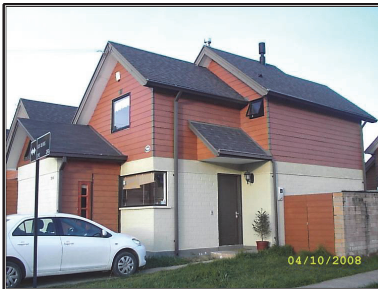
Figura 2.39: Casa de Mampostería, Valdivia, Chile.
