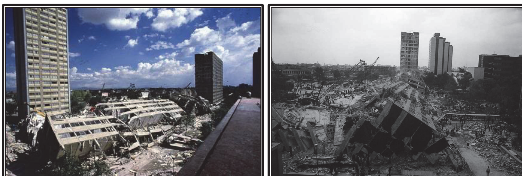
Figuras 3.11 y 3.12: Colapso del Edificio Nuevo León del Multifamiliar Tlatelolco, México, DF. (Ref. VI)
