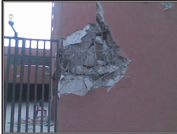
Figura 3.40: Edificio Centro Mayor, Concepción, Chile. (Ref. IV)
