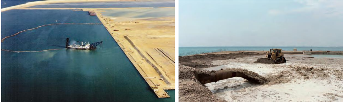
Figura 4.31. Relleno procedente de dragado.
