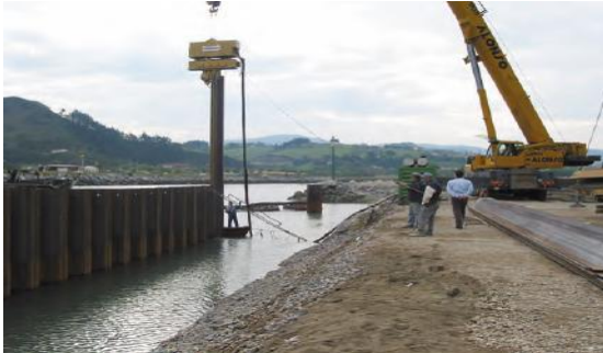
Figura 4.37. Hincado de tablestacas
