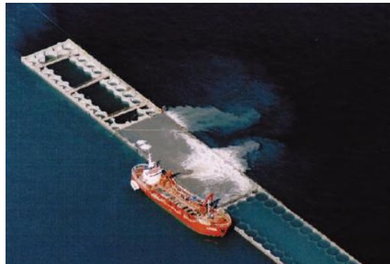
Figura 4.30. Relleno de dragado.
