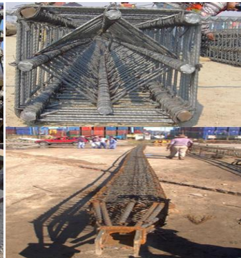
Figura 4.71 Acero de refuerzo
