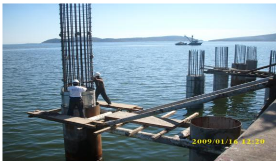
Figura 4.63. Colocación del acero de refuerzo.
