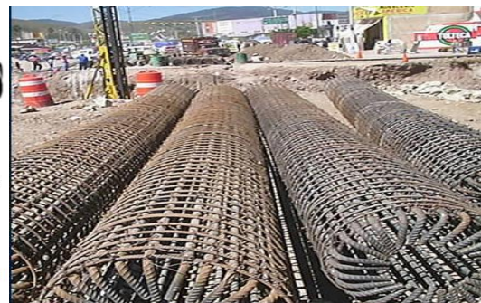
Figura 4.61 Acero de refuerzo en pilas
