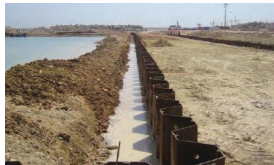
Figura 4.40. Relleno en pantalla de tablestacas.
