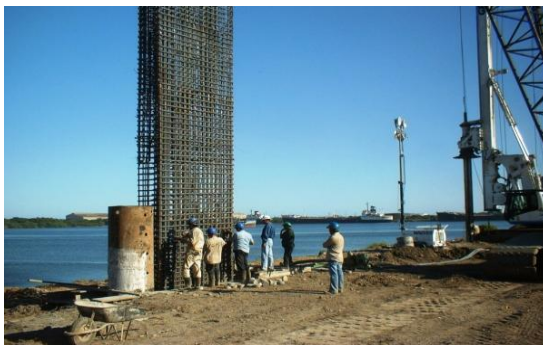
Figura 4.47. Manejo de los armados.
