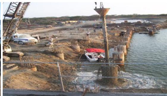
Figura 4.64. Colocación del concreto.
