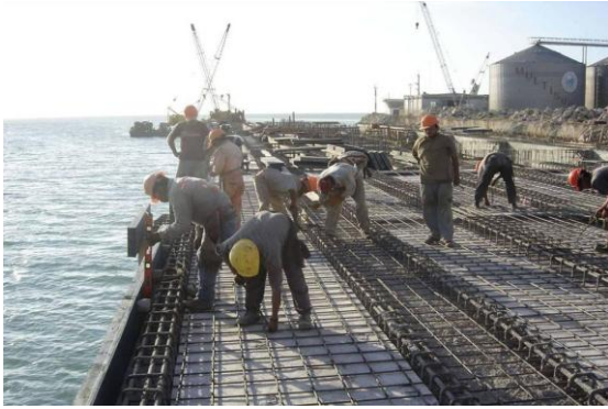
Figura 4.79. Acero de refuerzo en losa y pantallas
