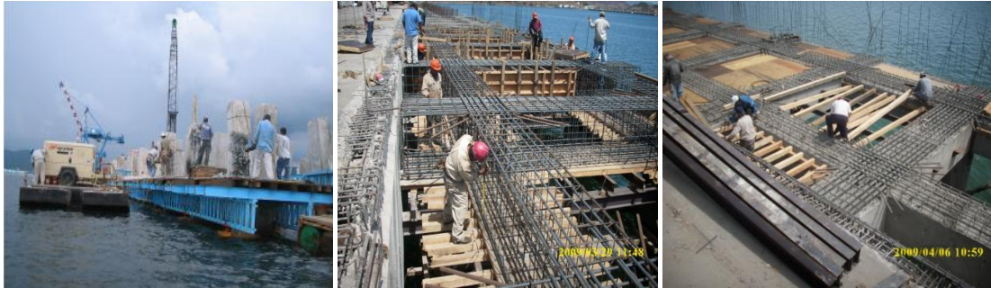
Figura 4.76 Obra falsa Fig. 4.77 Acero en trabes Fig. 4.78 Cimbra de losa
