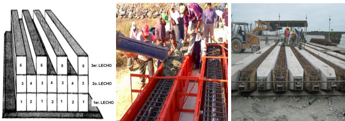
Figura 4.68. Secuencia de colado de pilotes.
