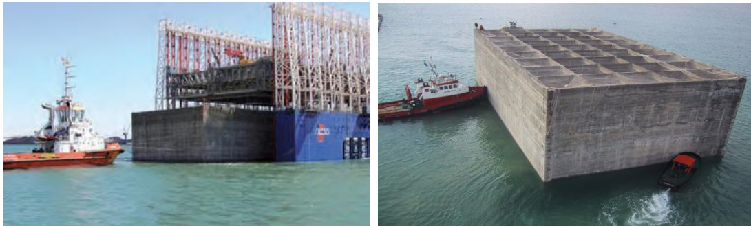
Figura 4.26. Botadura del cajón.
