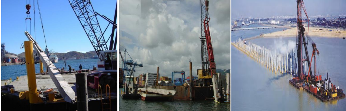
Figura 4.74. Hincado de pilotes.
