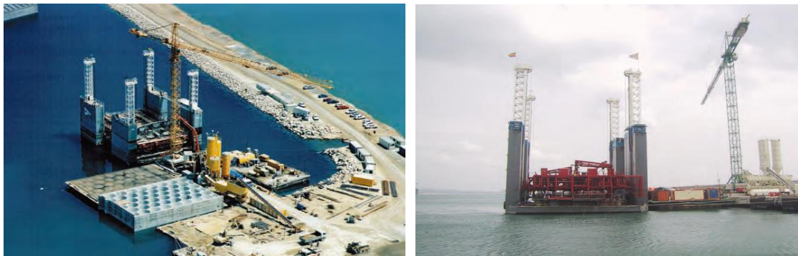
Figura 4.18. Fabricación de cajones.
