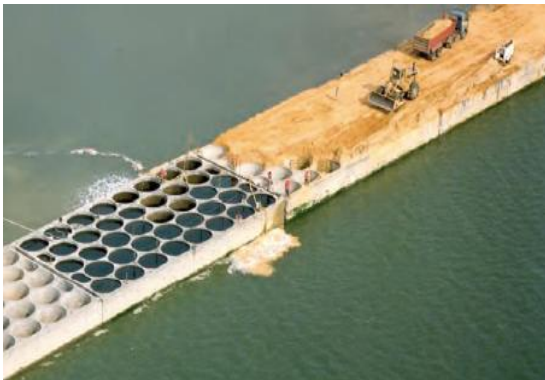
Figura 4.29. Relleno de préstamos.
