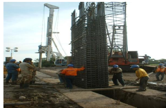
Figura 4.48 Colocación en la zanja.
