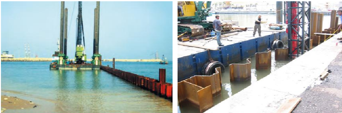
Figura 4.34. Hincada de tablestacas con medios flotantes.
