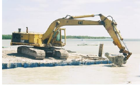
Figura 4.50. Dragado de material sobrante
