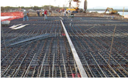
Figura 4.49. Construcción de superestructura
