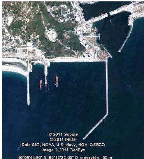
Figura 6.2 Situación actual de terminal marítima de PEMEX
