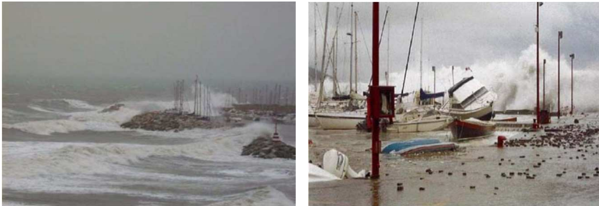
Figura 5.5 Daños generados por el rebase del oleaje extremo a rompeolas e instalaciones y embarcaciones
