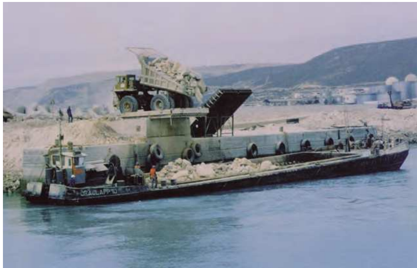
Figura 4.5 Cargadero de gánguiles
