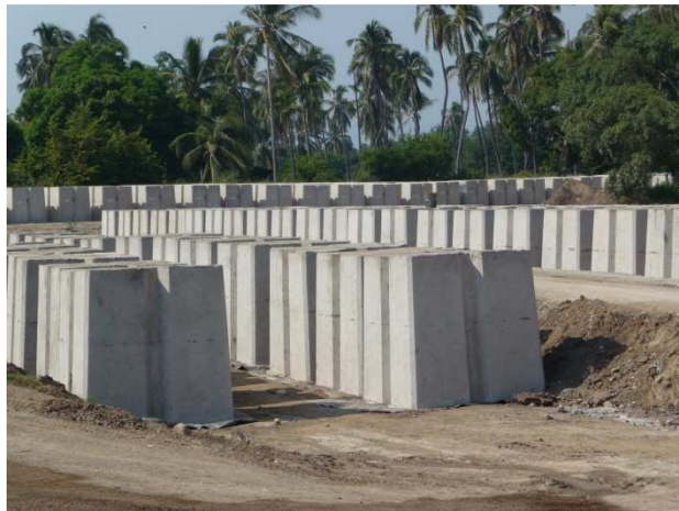
Figura 4.16 Patio de almacenamiento
