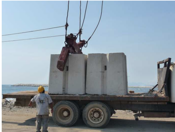
Figura 4.17 Traslado al sitio de la obra
