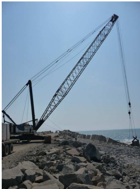
Figura 4.18 Colocación de elementos prefabricados
