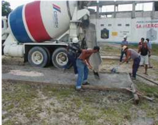
Figura 4.15 Construcción de patio de colado
