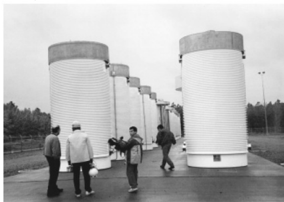
Figura 3.14 Campo de contenedores metálicos en la central de Surry (E.U.A.) [Fuente: Casanovas et al., 2000 ]
