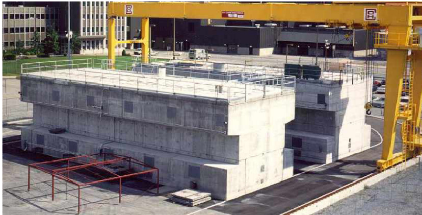
Figura 3.10 Instalación de almacenamiento en seco con tecnología MACSTOR en Canadá [Fuente: OIEA, 2002]
