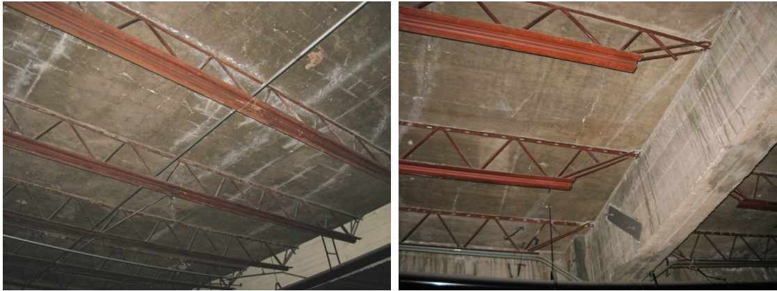
Figura 3.2 Refuerzos tipo “joist” en losas
