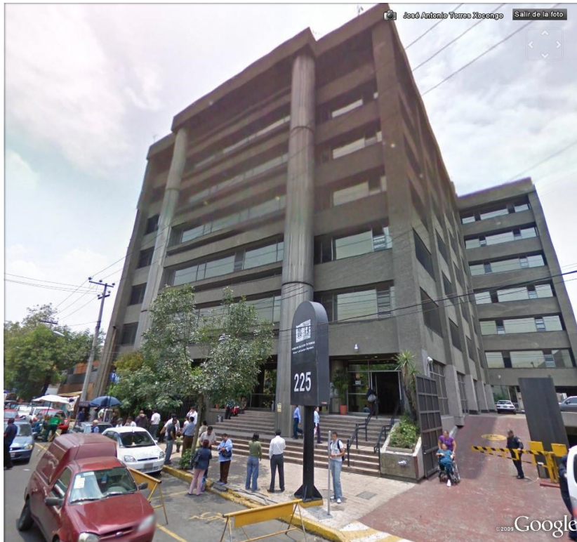
Figura 3.1 Vista de la fachada del edificio
