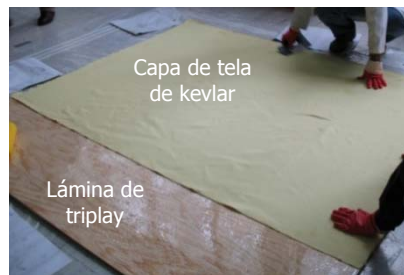
b. Construcción de la plataforma de trabajo.
