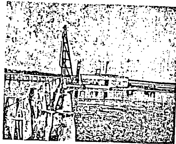
CONSTRUCCION DE UN DIQUE DE PILOTES EN LA ZONA DE LA CIUDAD DE NEBRASKA, RIO MISSOURI.
