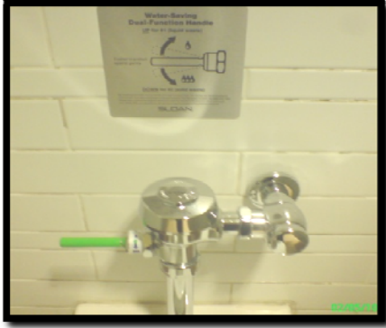
Figura 4.1 Fluxómetro de doble descarga. En el aeropuerto de Calagary, Canadá, los inodoros cuentan con la tecnología dual-flush handle que permite ahorrar agua, suministrando una descarga de cuatro litros si se sube la manija, y de seis litros si se baja. Fuente: Tomada por la autora.
