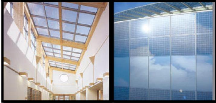
Figura 3.11 Tipos de cristales en la tecnología BIPV. Pueden ser transparentes (izquierda) o semitransparentes (derecha) adecuándose al diseño del edificio. Fuente: Sitio web *BIPV Building Integrated Photovoltaics*
