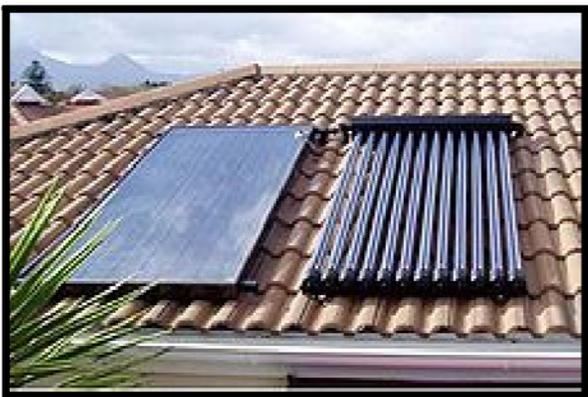
Figura 3.5 Tipos de calentadores solares. Colector de placa plana (izquierda) y colector de tubos de vacío (derecha). Fuente: Sitio web *Solar Heat Water, Heating and Cooling Systems*.
