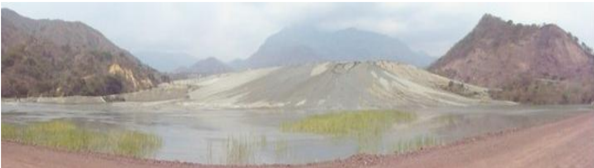
Figura 2.5 Presa de Jales colima fuente: Mota, 2011.
