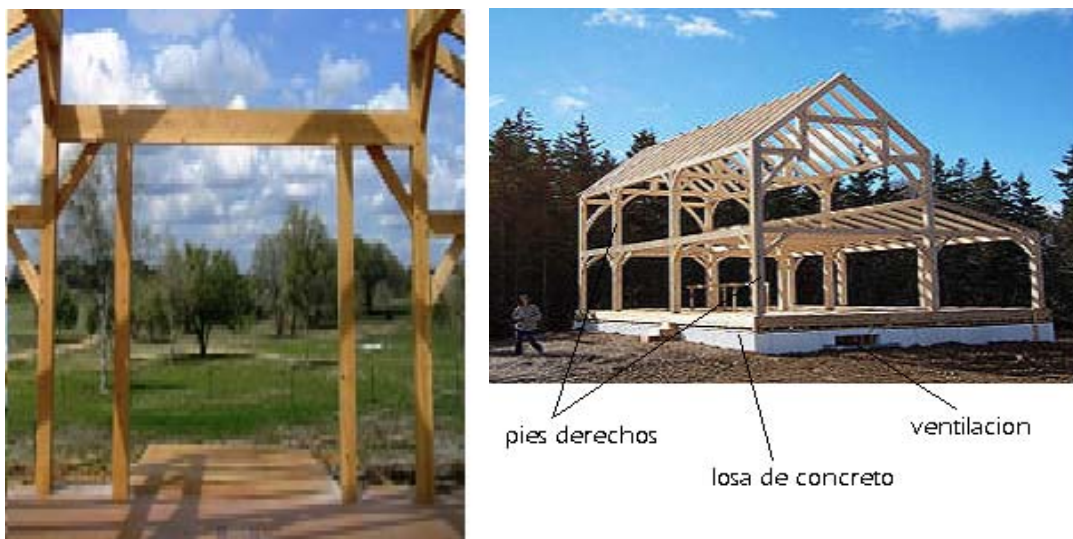
Figura 164. Muros de madera maciza de primero y segundo piso.
