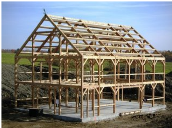
Figura 183. Pies derechos empotrados en losa
