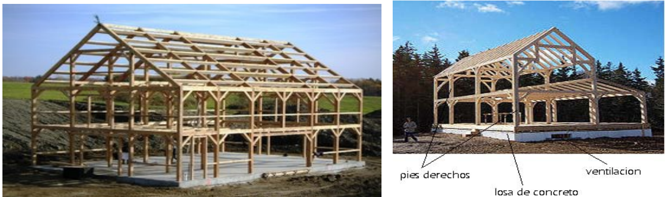
Figuras 160 y 161. Pies derechos empotrados directamente sobre la losa y pies derechos empotrados sobre las soleras inferiores y superiores de madera.
