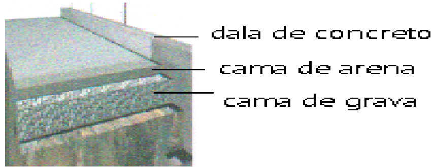
Figura 152. Detalle de la colocación de cama de arena y grava.
