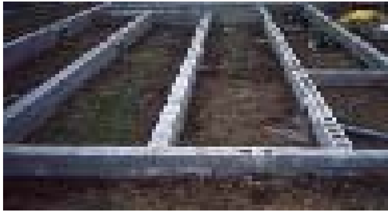
Figura 145. Cimentación superficial de concreto armado.
