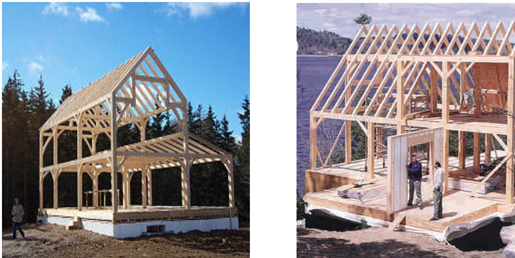
Figura 125. Estructura con elementos de madera maciza.
