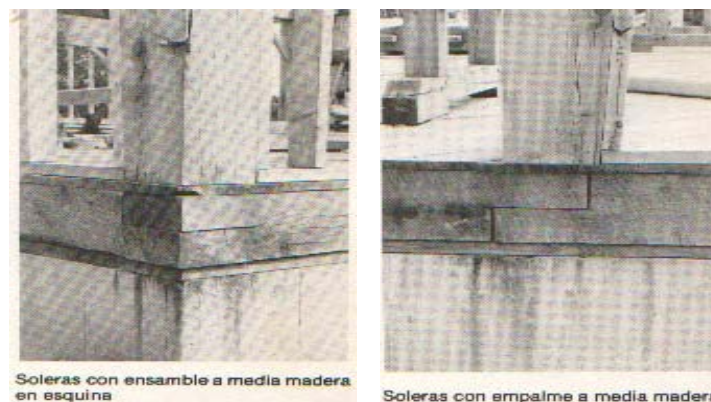
Figura 75. Soleras a media madera formando esquinas y para aumentar la longitud
