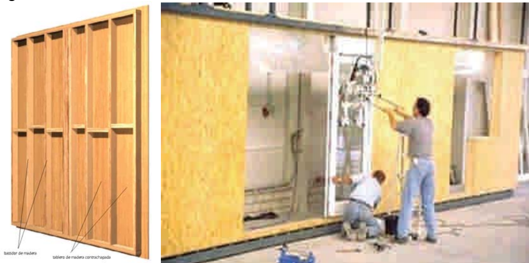
Figura 124. Bastidores de madera con revestimiento de tableros, armado en módulos.
