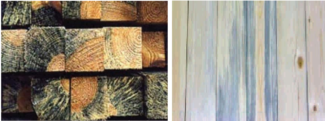
Figura 50. Hongos en la madera.
