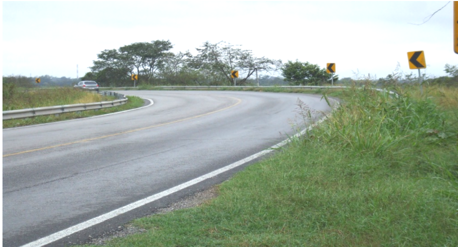
Figura 5.7. Fotografía donde se aprecia el recubrimiento de los taludes con vegetación de la región.
