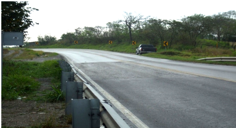
Figura 5.8. Fotografía donde se aprecian los cortes, los cuales no presentan deslizamientos.
