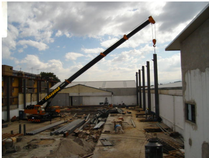
Fig. V.1 Montaje con grúa.
