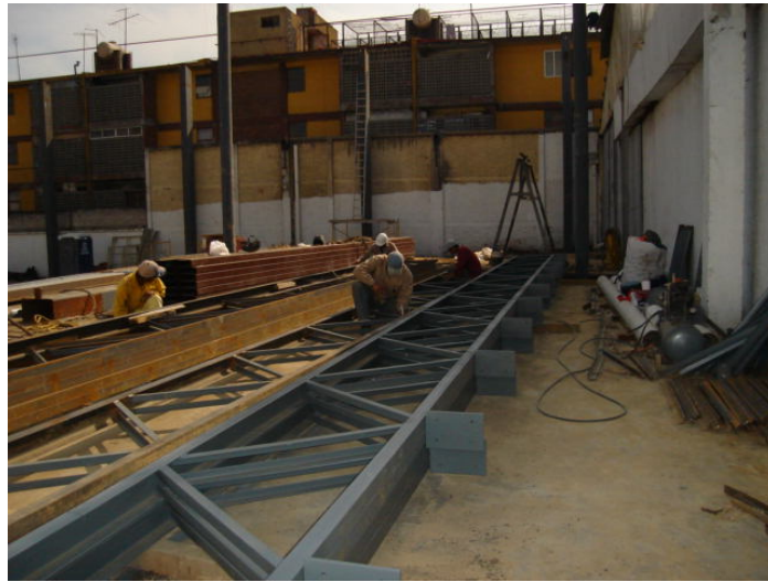
Fig. IV.5 Ensamblado y preparación de armadura para su montaje.
