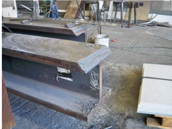
Fig. IV.2 Preparación de borde para la aplicación de soldadura
