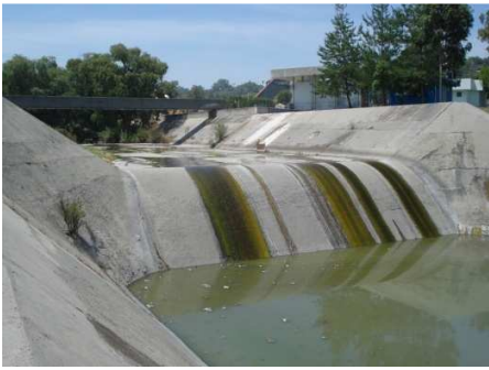
Fig. 2.10 Tanque amortiguador del Río el Salto
