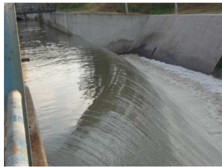
Fig. 2.5 Vertedor de Excedencias
