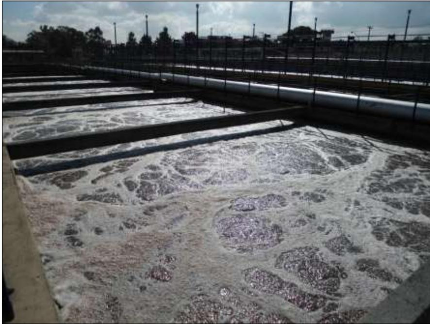
Figura 5.4. Sistema de Lodos Activados Planta de Tratamiento Cerro de la Estrella.
