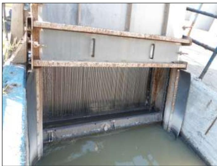
Figura 5.2. Sistema de criba tamiz Planta de Tratamiento Cerro de la Estrella.
