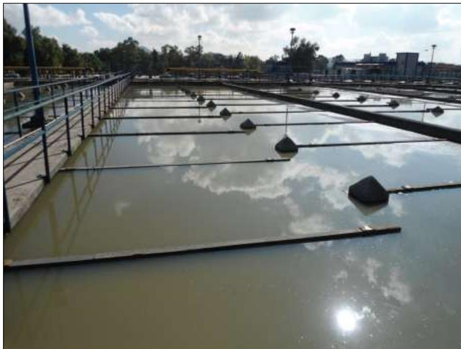
Figura 5.3. Sedimentador primario Planta de Tratamiento Cerro de la Estrella.
