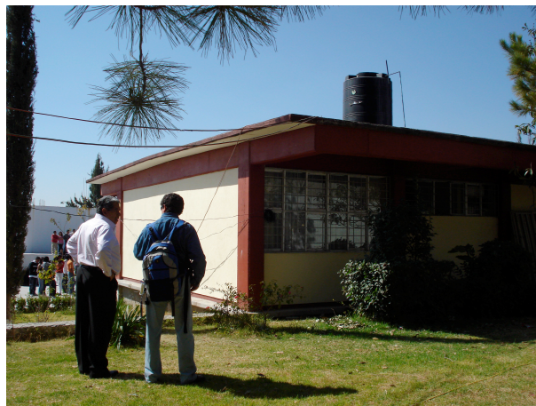
Figura 4.7. Azotea del sitio de monitoreo.
