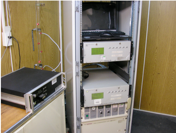
Figura 4.21. Vista interior de la unidad móvil de monitoreo atmosférico.
