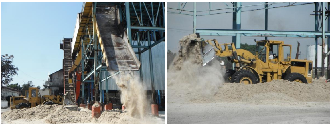
Figura 4.28 Patio de almacén de bagazo excedente.
