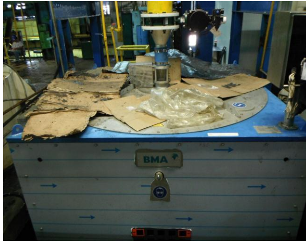
Figura 4.39 Instalación de equipo de centrifugación de alta eficiencia y ahorro de energía.
