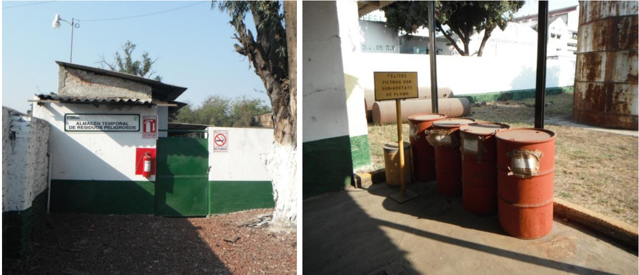
Figura 4.50 a) Almacén temporal de residuos peligrosos b) Forma de almacenamiento de filtros con sub-acetato de plomo
