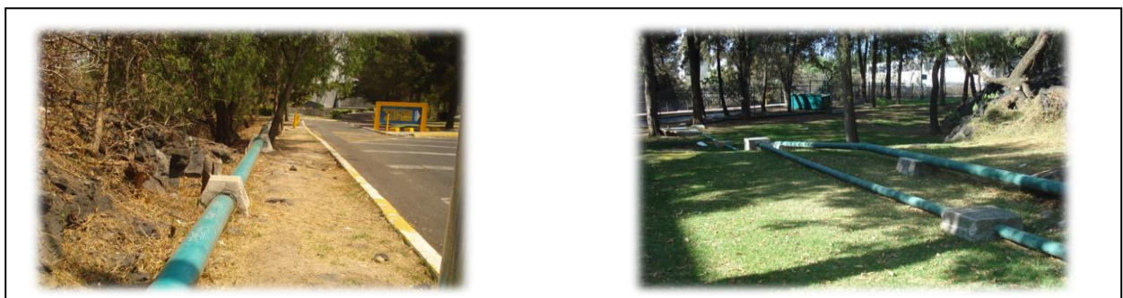
Figura 3.17 a) y b).- Tubería superficial de agua potable.
