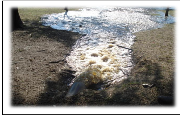
Figura 3.18.- Desfogue o purga del crucero “Los bigotes” en el sector hidráulico IV.
