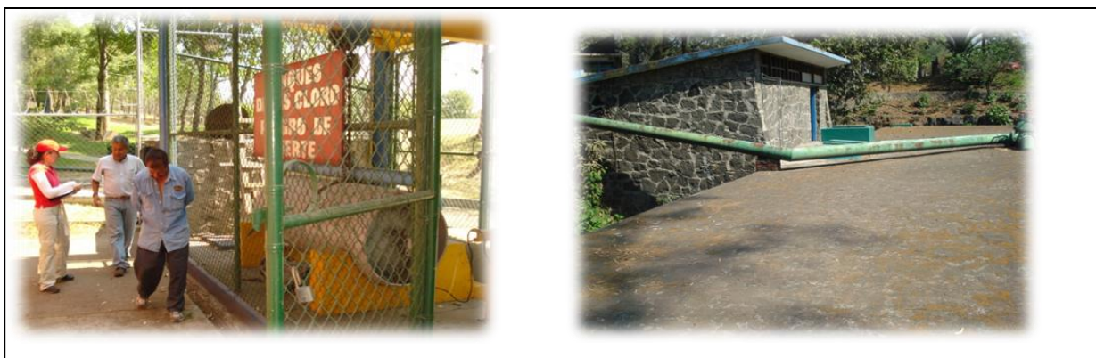
a) Sistema de desinfección pozo vivero alto b) Tanque bajo
