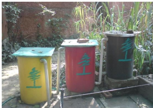
Figura 2.4. Sistema de captación de lluvia de la casa ecológica del parque Loreto y Peña Pobre, Ciudad de México.
