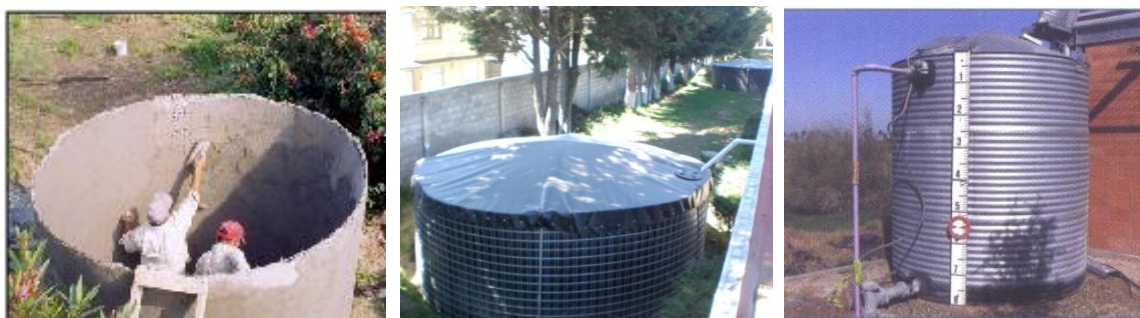
Figura 5.3. Depósitos de almacenamiento de agua de lluvia. De izquierda a derecha, tanque de ferrocemento, quicktank de geomembrana y de lámina metálica.
