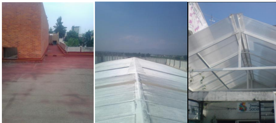
Figura 5.1. Diferentes tipos de techo como superficies de captación. De izquierda a derecha, cemento impermeabilizado con terminado en gravilla, lámina metálica y policarbonato.
