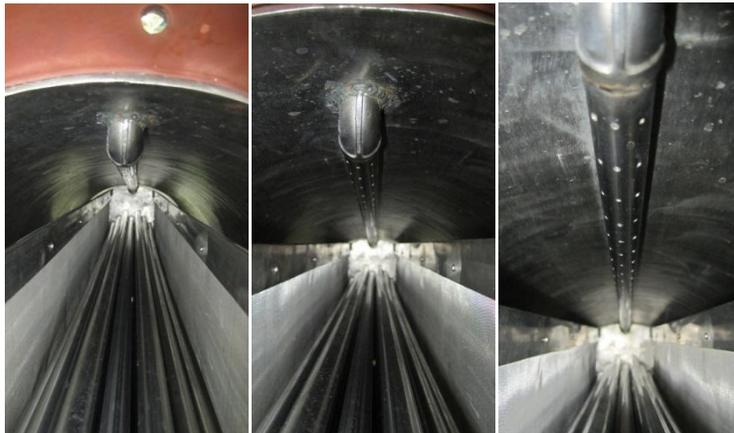
Figura 4.8 Distribuidor de agua de alimentación
