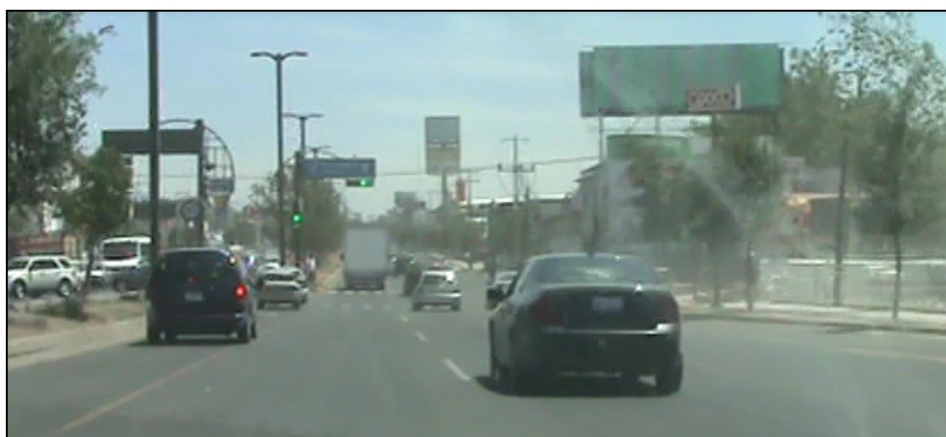
Foto 5.13, Carretera federal 120, dirección norte - sur. Abril de 2012
