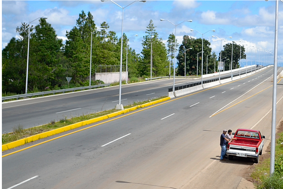
Figura 6.54 Paso superior vehicular en la carretera federal 105.
