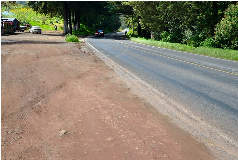
Figura 6.52 Derecho de vía que se pavimentará para la ampliación del camino (dirección Atotonilco-Pachuca).
