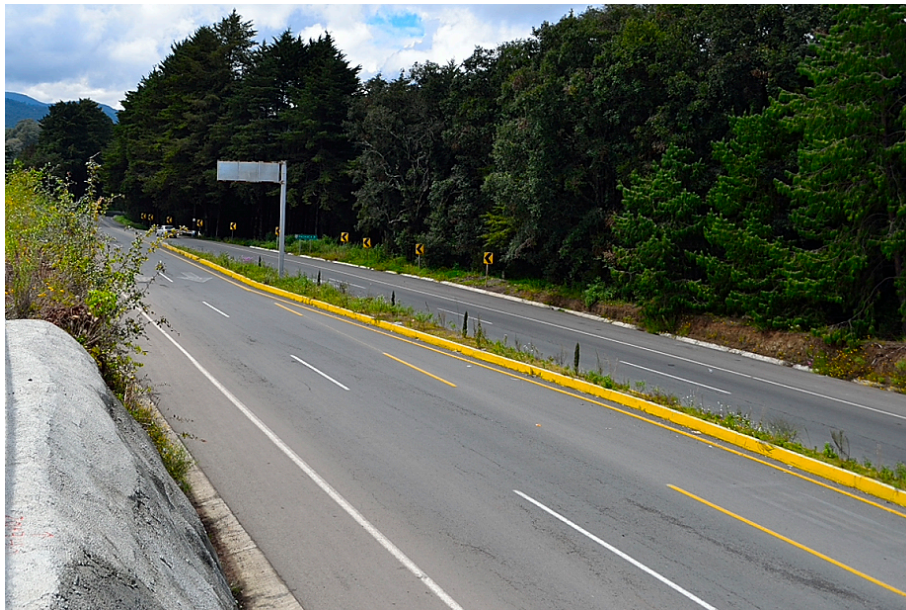
Figura 6.8 Señalamiento horizontal en dirección norte de la carretera federal 105 en el tramo del entronque con el nuevo tramo.
