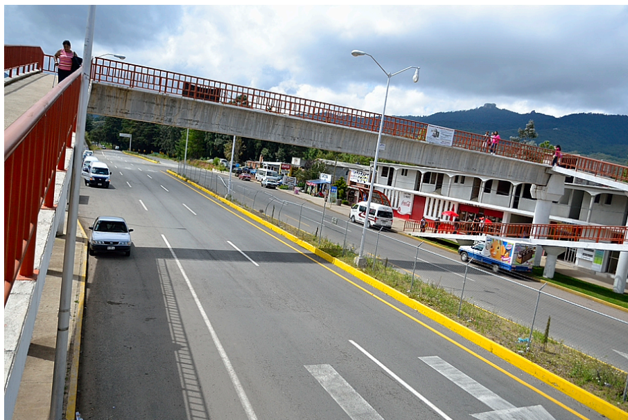
Figura 6.53 Puente peatonal en la carretera federal 105.
