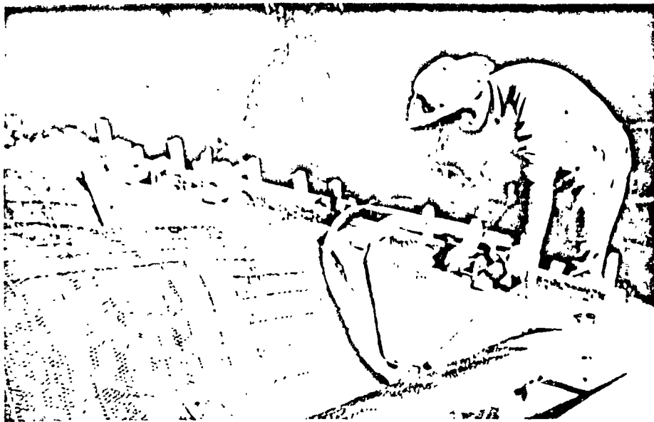
Montaje de una sección prefabricada de ferrocemento.
