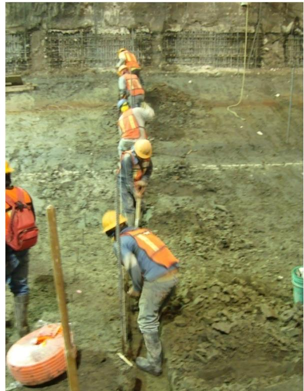
Foto 6.- Realización de zanja para guiar el cable de señal cuidando la plantilla
