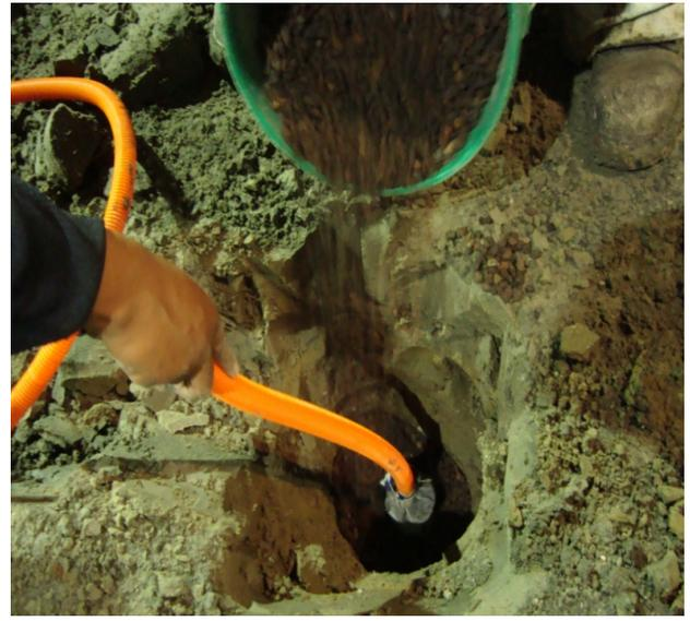
Foto 4.- Colocación de filtro para piezómetro
