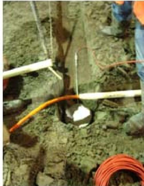
Foto 2.- Colocación de celda en el sitio
