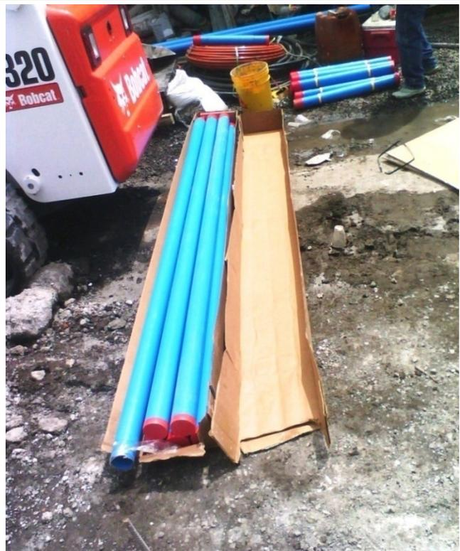
Fotos 5 y 6.- Primer tramo de tubería y material listo para armarse e hincarse en la estación Mexicaltzingo.
