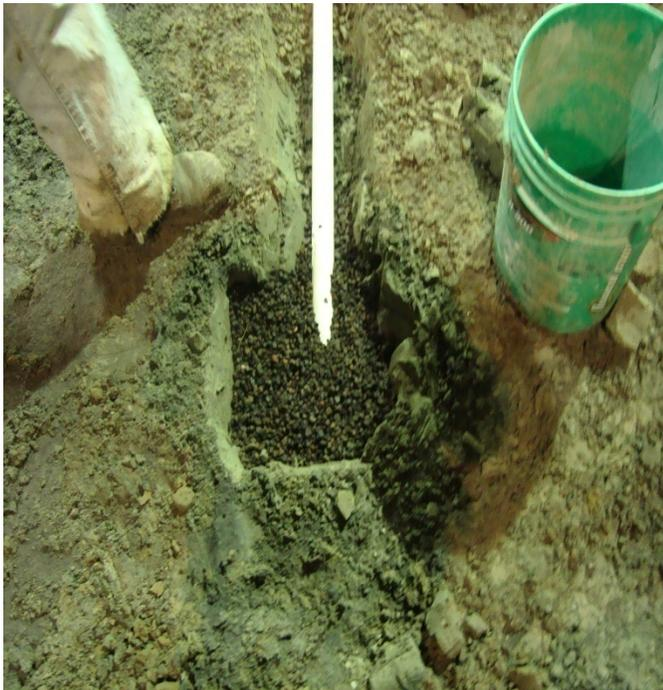
Foto 5.- Terminación de la fosa de alojamiento del Piezómetro.
