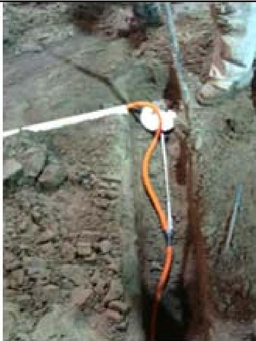
Foto 3.- Protección de cable de señal con poliducto flexible
