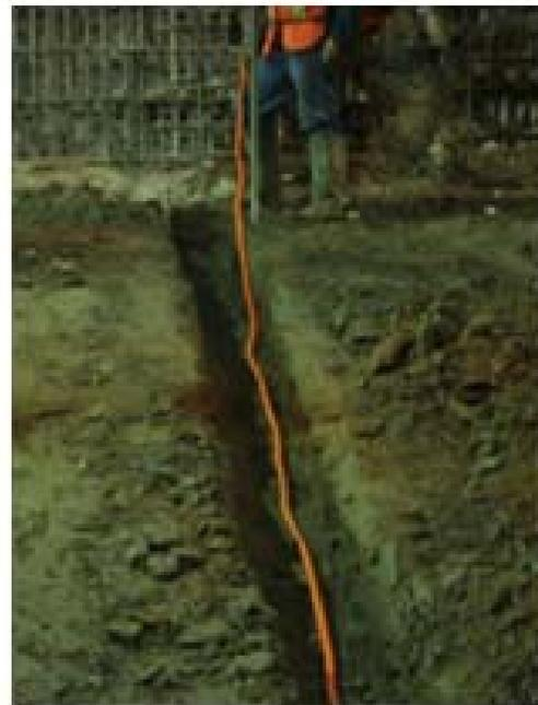
Foto 4.- Realización de zanja para guiar el cable de señal cuidando la geometría de la plantilla
