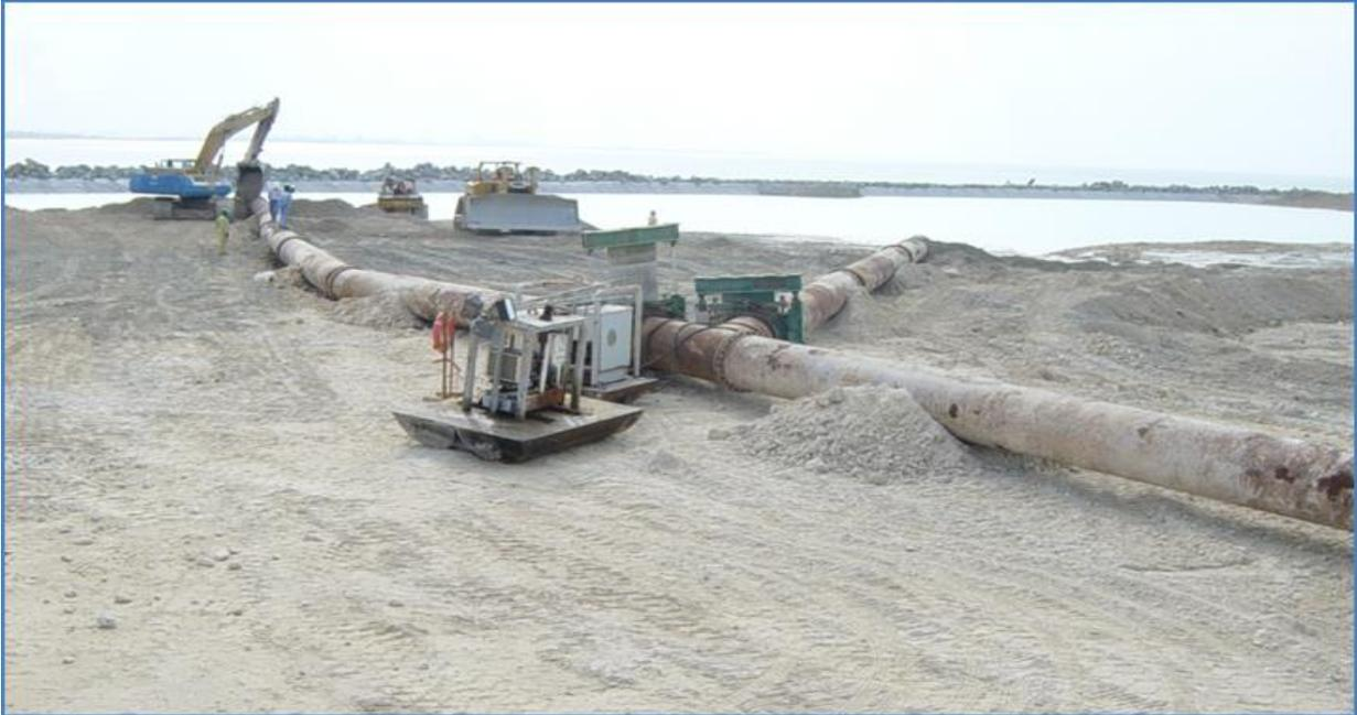
Figura 21. División de la tubería hacia diferentes áreas
