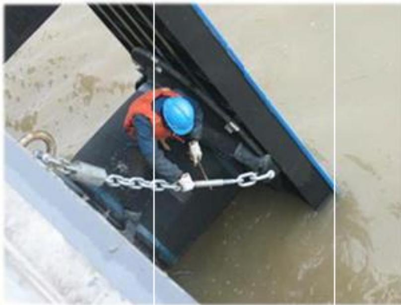
*Figura 57. Sujeción y anclaje de panel de absorción de polietileno.*
