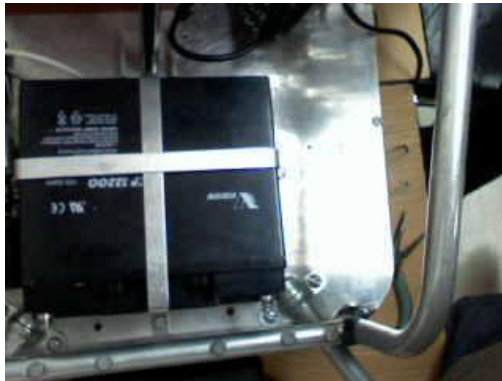
Figura 83. Batería acoplada a la estructura.
