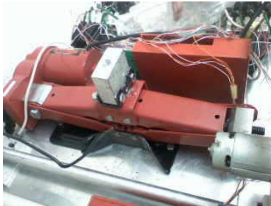
Figura 80. Ensamble de gato eléctrico a la estructura.
