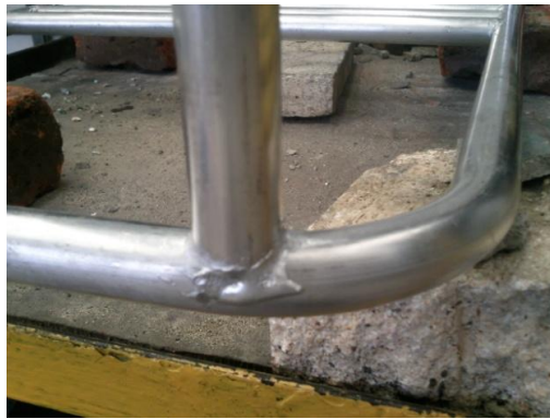
Figura 55. Soldadura aplicada en la estructura.
