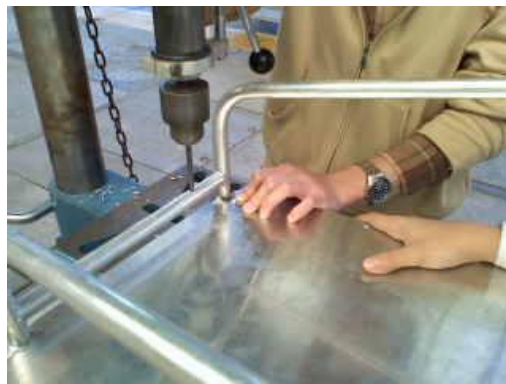
Figura 58 .Barreno a estructura y lámina.
