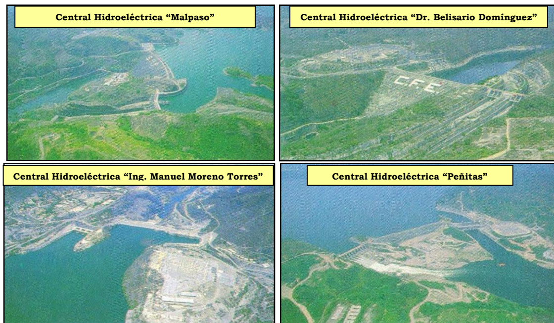
Figura 1.18 Perspectiva aérea de las Centrales Hidroeléctricas ubicadas en el Complejo Grijalva. (CFE, 1988)
