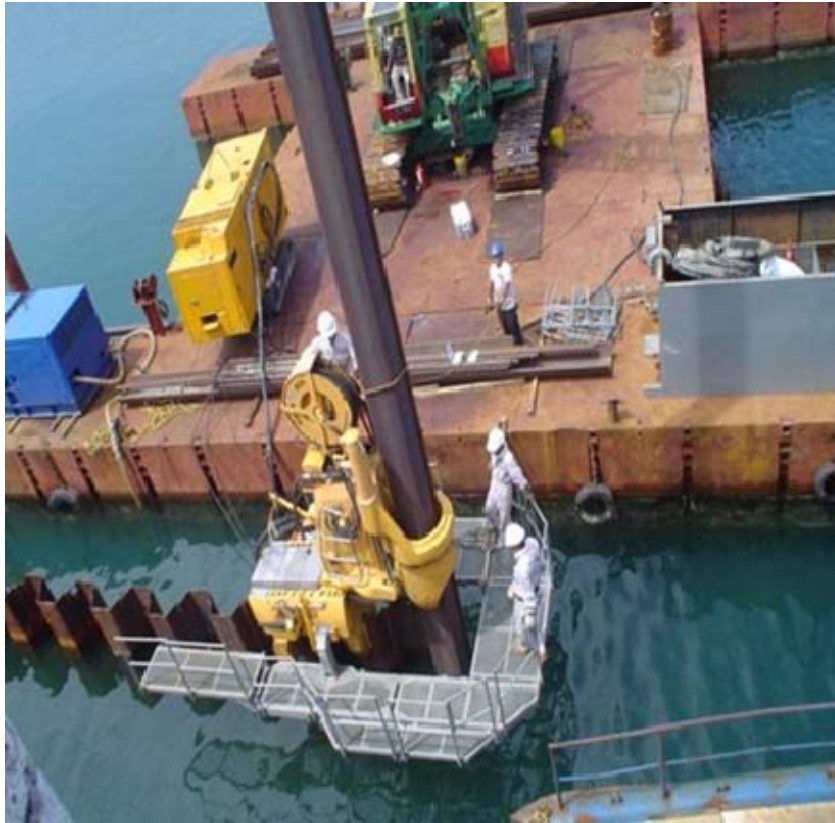
Fig. 3 Tablestacado frente a la fortaleza de San Juan de Ulúa en el puerto de Veracruz. Se hincaron 700m de tablestaca de 18 m de longitud con equipo especializado (piloteadora hidráulica) a base de presión cuasi-estática sin producción de vibraciones mecánicas
