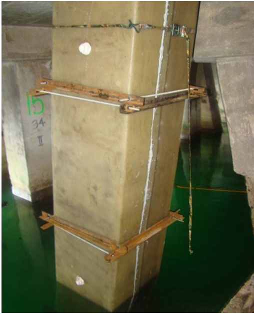
Figura 44. Pilote preparado para inyección.
