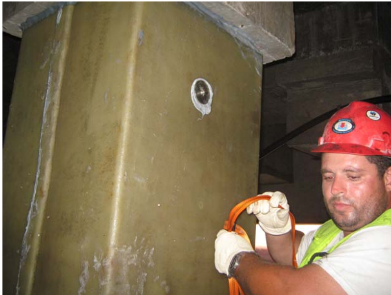
Figura 50. Perforación y toma de muestra de adherencia
