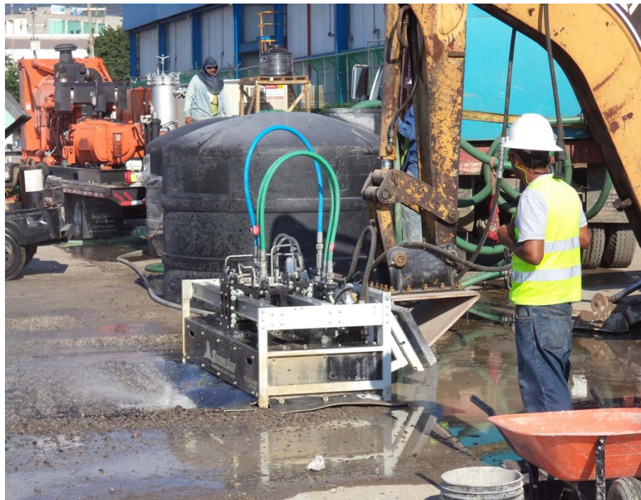
Fig. 2 Rehabilitación del muelle de pescadores en Manzanillo, Col. Hidrodemolición de 850 m 3 de concreto sin dañar la estructura del muelle con vibraciones mecánicas. Para este procedimiento se emplearon bombas de alta presión con capacidad de 20,000 a 40,000 psi, además de un cortador hidráulico con movimiento transversal y rotatorio para concreto montado en una retroexcavadora.
