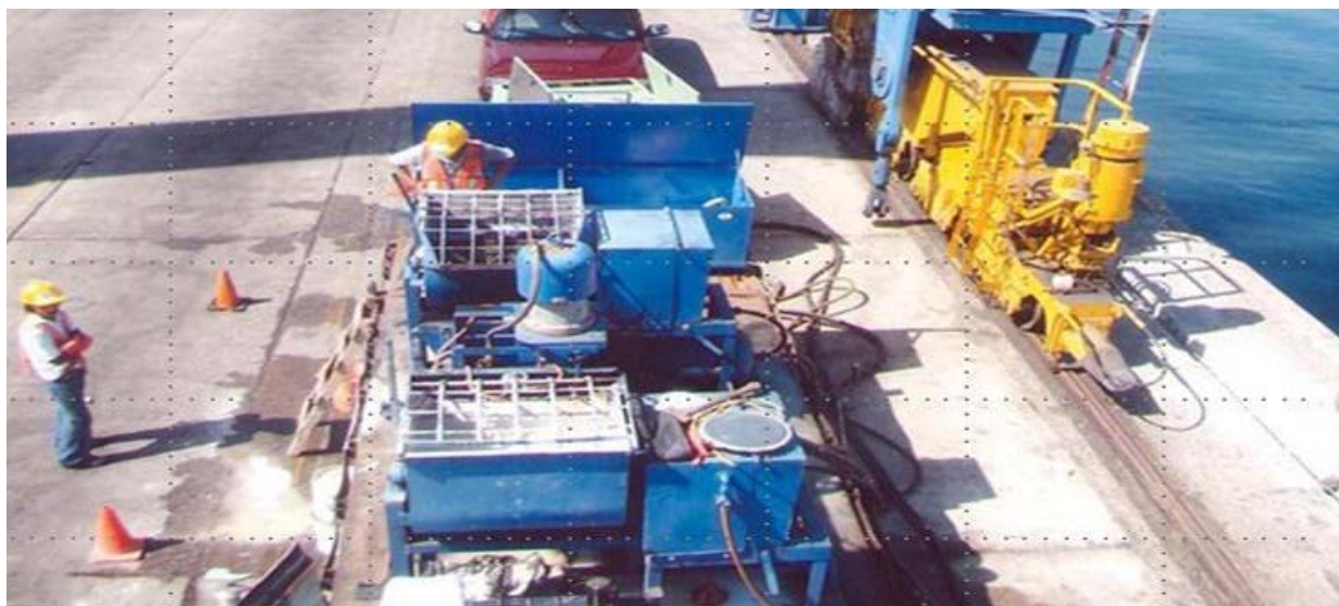
Figura 47. Equipo de inyección de grout epoxico
