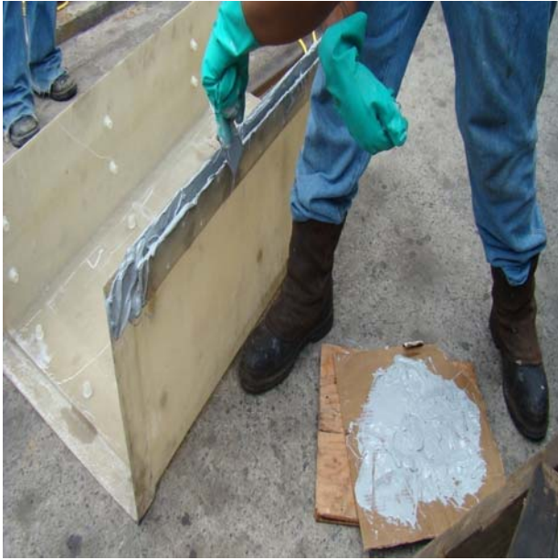
Figura 40. Aplicación de sellador en junta de camisa.
