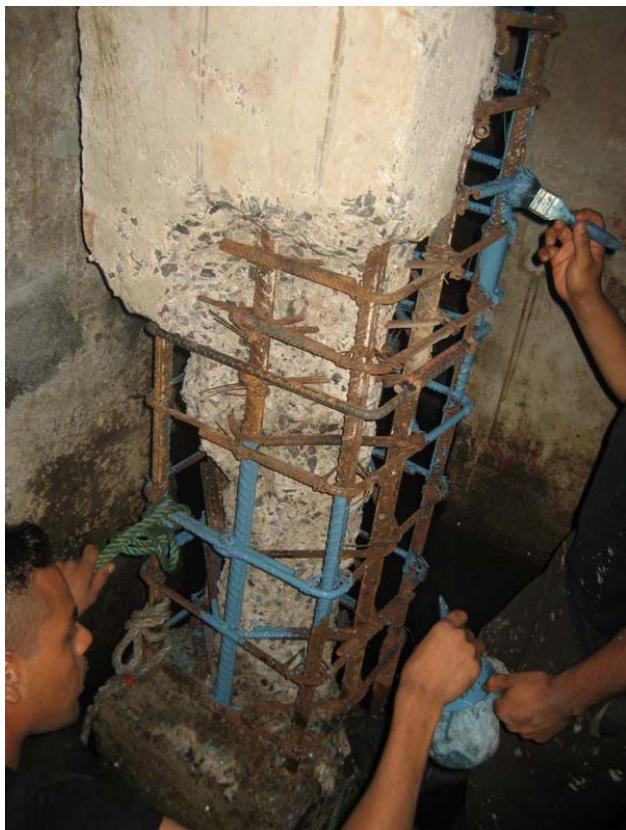
Figura 38. Sustitución de acero de refuerzo
