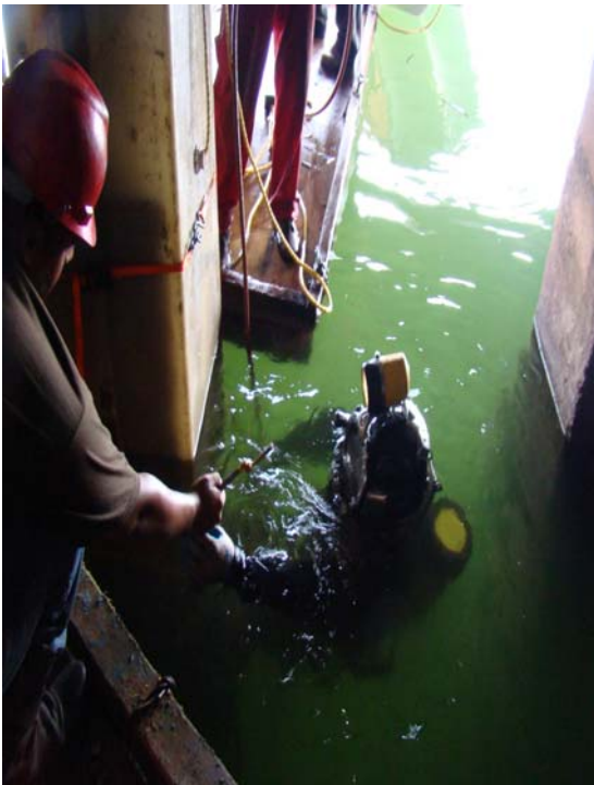
Figura 42. Colocación de sujetadores
