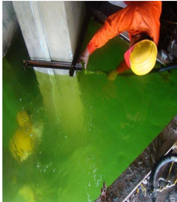
Figura 46. Inyección de grout epoxico bajo el agua
