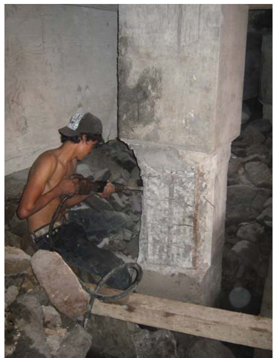
Figura 37. Demolición del concreto dañado
