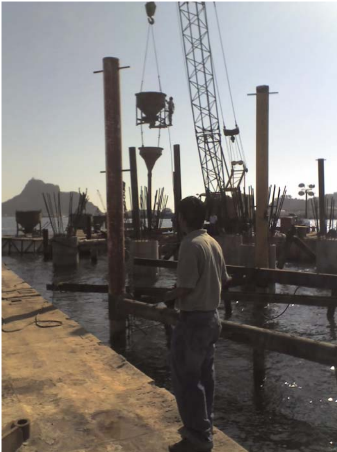
Fig. 6. Colado de pilas
