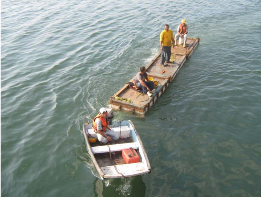
Fig. 21 Obra falsa con base en balsas de madera con alma de poliestireno
