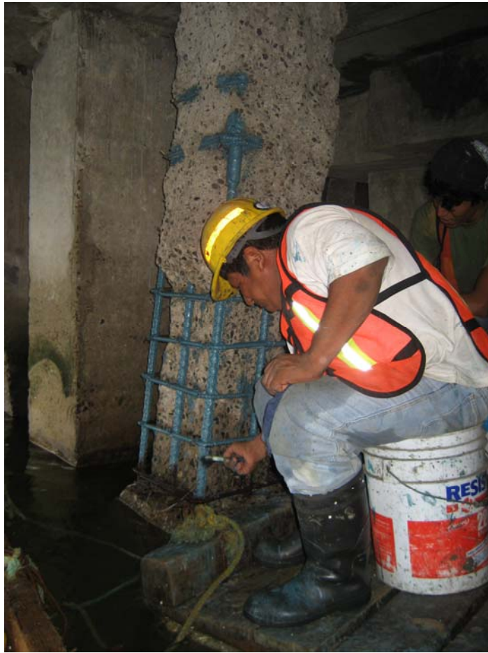
Fig. 23 Aplicación de inhibidor Reparación tipo (PR)
