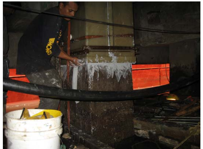
Figura 43. Colocación de sello inferior.
