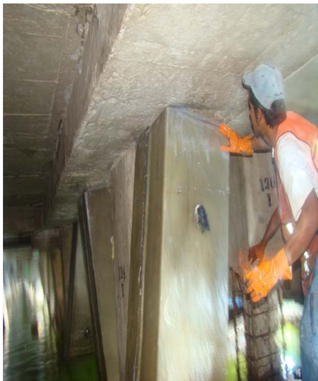
Figura 48. Colocación de sello superior
