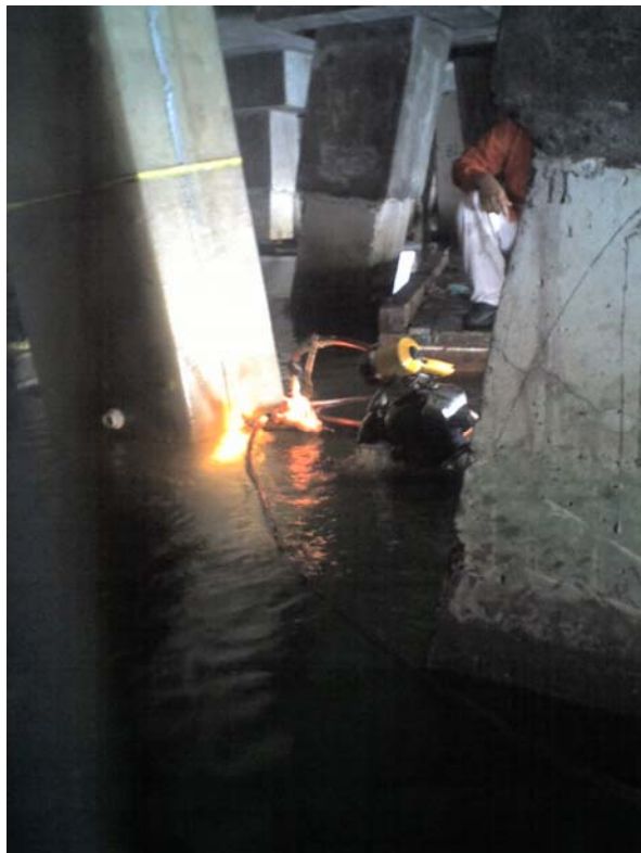
Fig.26 Inyección del grout epoxico en reparación tipo (SJ)
