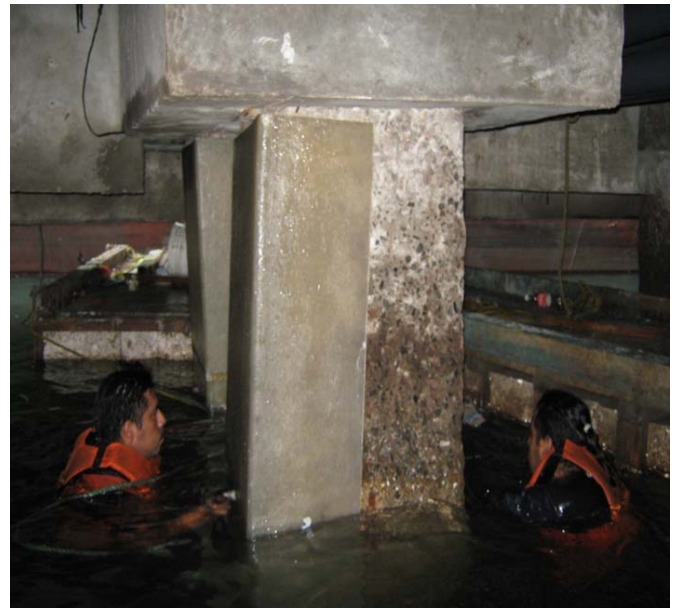
Figura 41. Colocación de camisa de fibra de vidrio.
