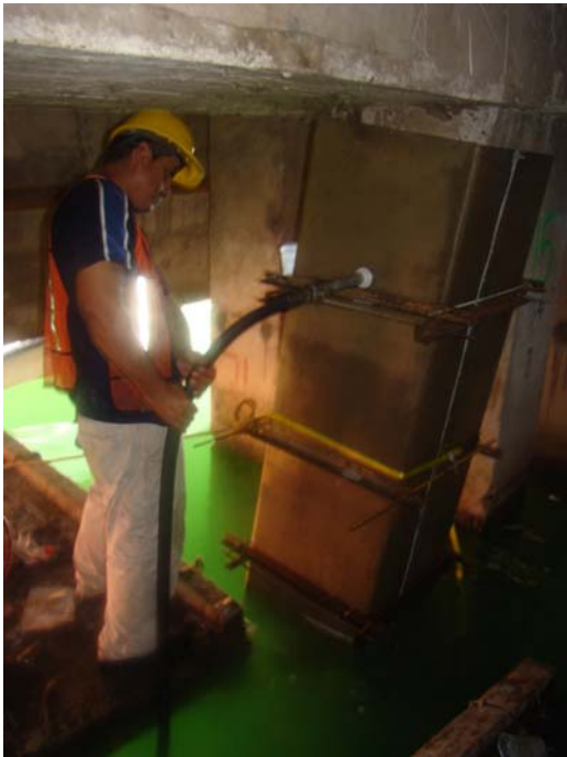
Figura 45. Inyección de grout epoxico en la superficie
