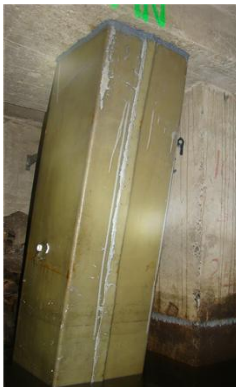
Figura 49. Pilote completamente encapsulado y reparado
