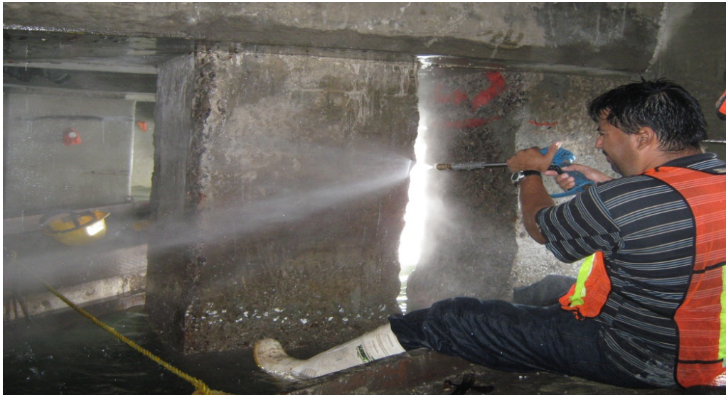
Figura 35. Limpieza de la superficie
