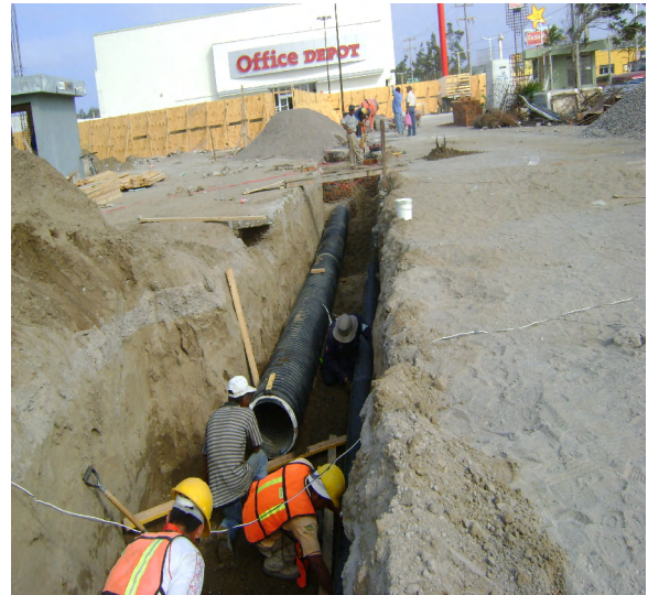
Instalación de tubería PAD de 30cm de diám.
