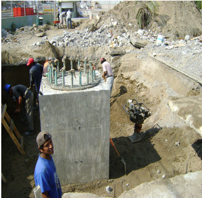
Relleno compactado al 90% Proctor con material producto de excavación y vista de tótem colocado.
