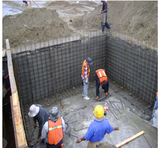
Construcción de cuarto de bombas.
