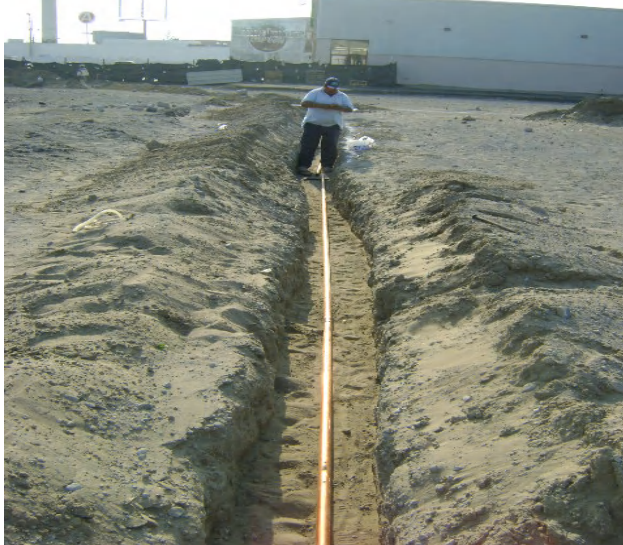
Colocación de tubería de cobre tipo M de 38mm.
