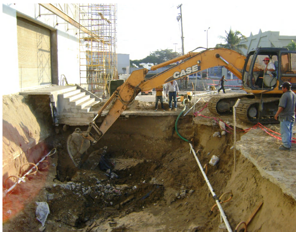
Excavación por medios mecánicos en cisterna en material limo-arenoso.
