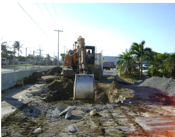
Excavación por medios mecánicos de tótem.
