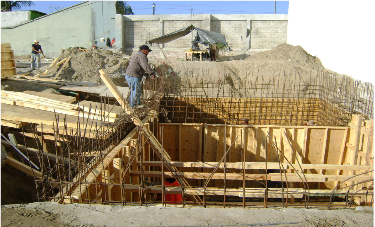
Cimbra aparente en muros de cisterna.
