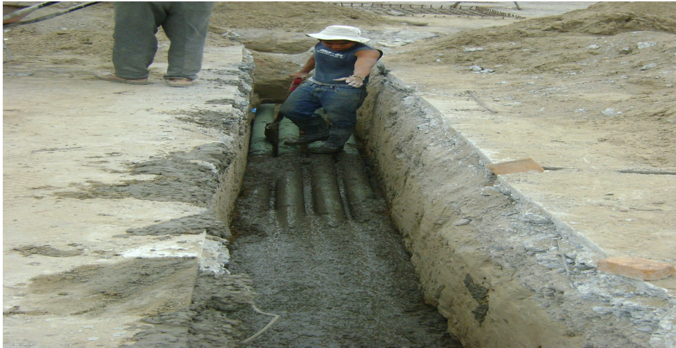
Encofrado de tuberías de media tensión, con concreto f'c = 200 \text{ kg/cm}^2 .
