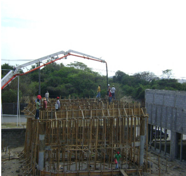
Colado de traveses de losa de azotea Italian Coffee.
