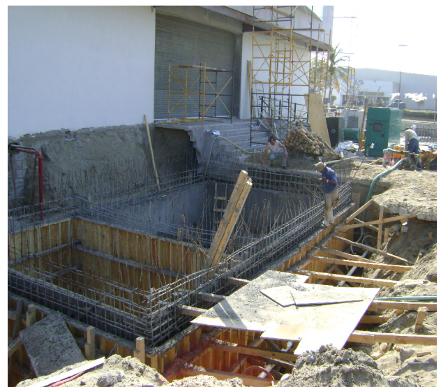
Descimbrado de muros en cisterna.
