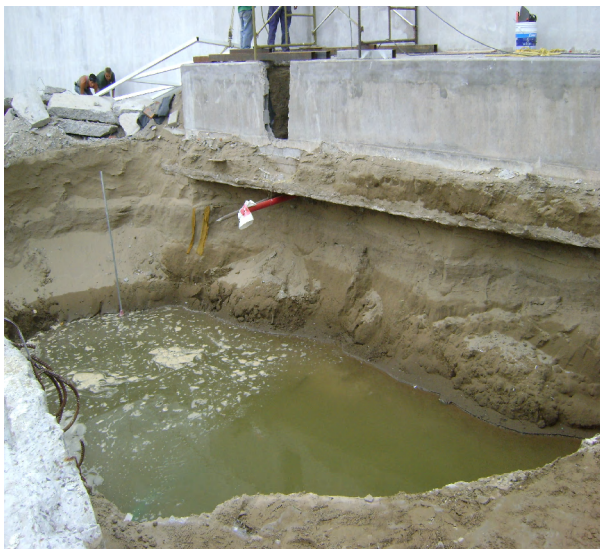
Nivel freático de la cisterna.
