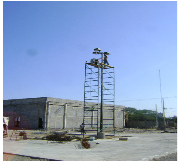
Colocación de luminarias en los postes.
