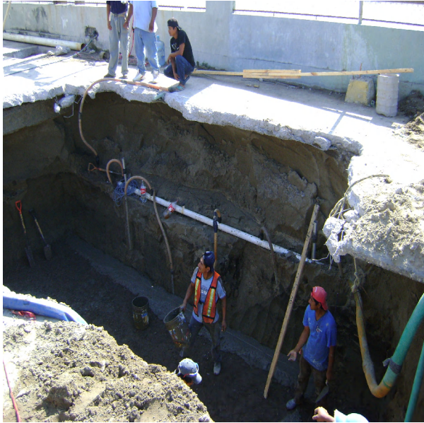
Colocación de plantilla de concreto f'c=100\text{kg/cm}^2 para protección del acero de refuerzo.
