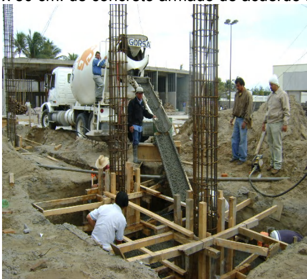
Colado de zapatas aisladas y traveses de liga.
