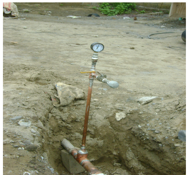
Prueba hidrostática a la línea de alimentación.
