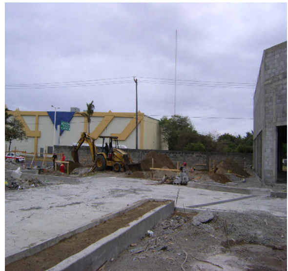
Excavación de zapatas de cimentación con retroexcavadora.
