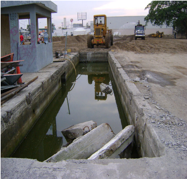
Foso existente utilizado para cisterna.
