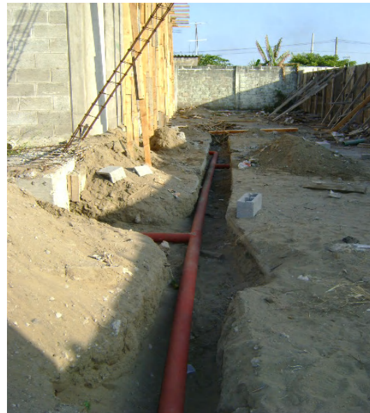
Tendido de tubería de acero al carbón de 4" y 2" de diámetro cédula 40.
