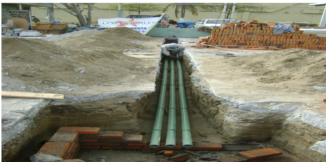
Instalación de tuberías de PVC tipo pesado de 3" de diámetro.
