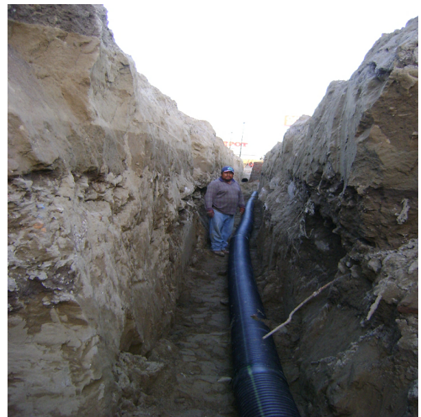
Instalación de tubería PAD de 25 cm de diám.
