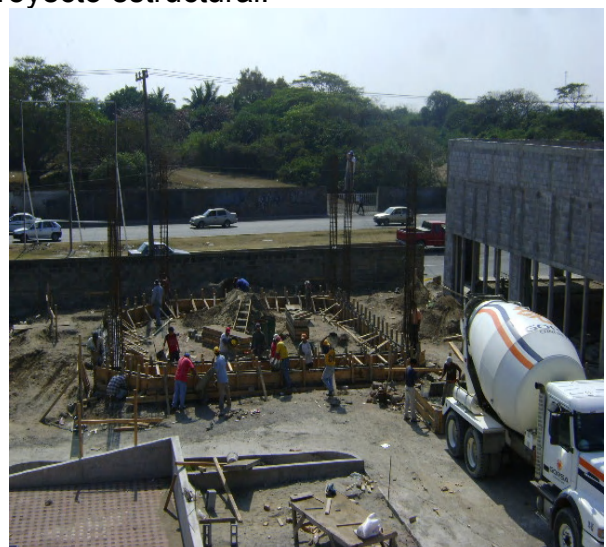
Colado de zapatas aisladas y traveses de liga.
