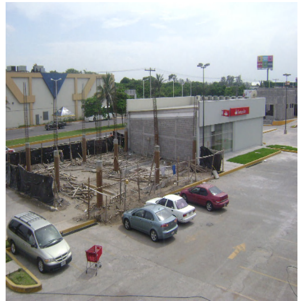
Sembrado de columnas de concreto Nextel.
