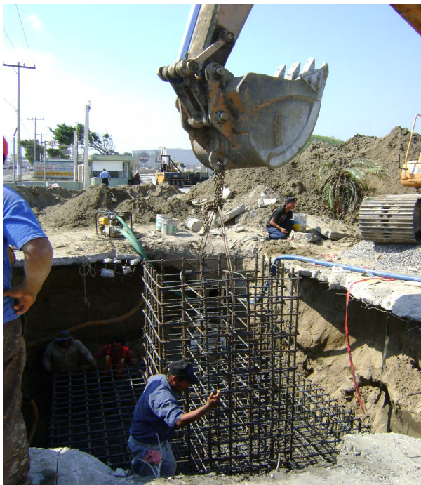
Colocación de acero de refuerzo de cimentación del tótem y colado con concreto premezclado.
