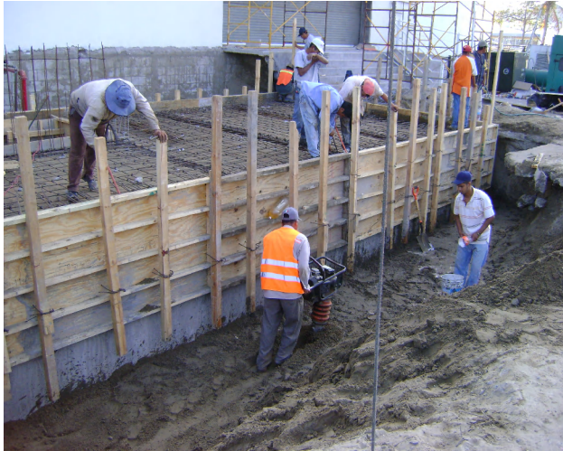
Cimbrado de losa tapa y relleno compactado exterior.
