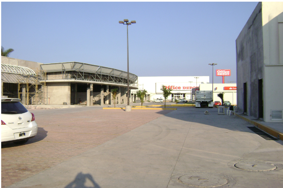
Vista interior de la Plaza de poniente a oriente.
