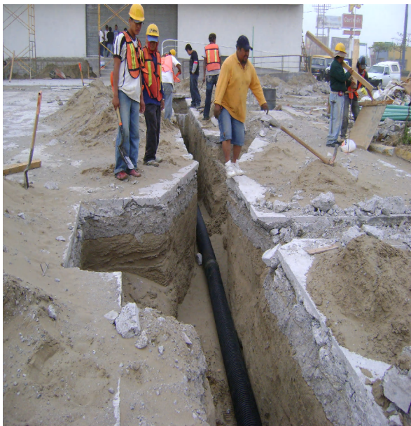
Instalación de tubería PAD de 20 cm diám.
