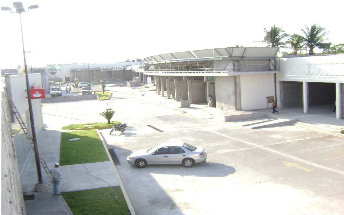
Vista interior de la Plaza de oriente a poniente.
