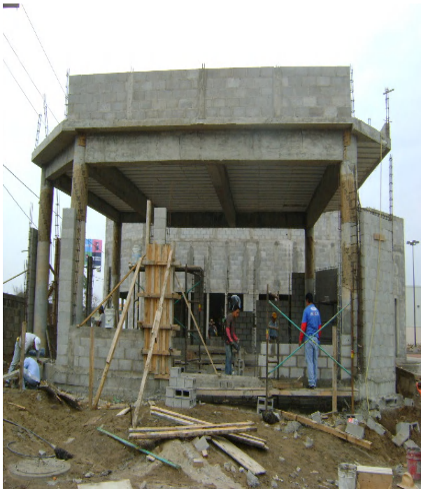
Desplante de muros y castillos de Italian Coffee.
