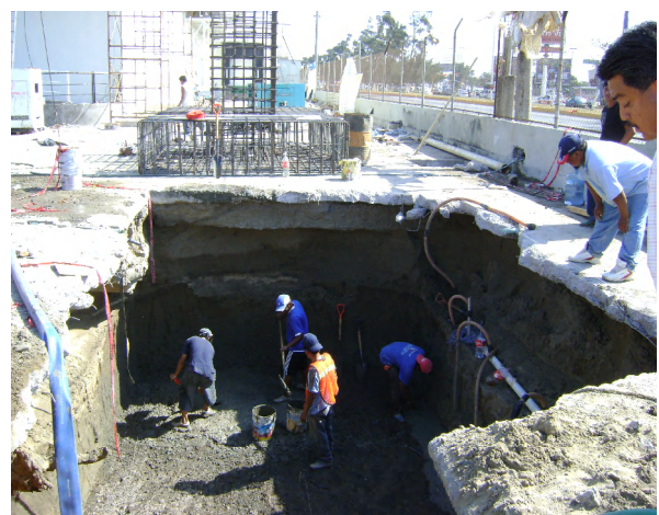
Plantilla de concreto pobre de 7cm de espesor.
