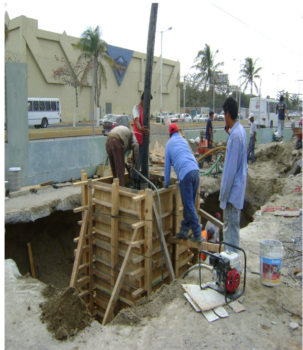
Colocación de acero de refuerzo de cimentación del tótem y colado con concreto premezclado.
