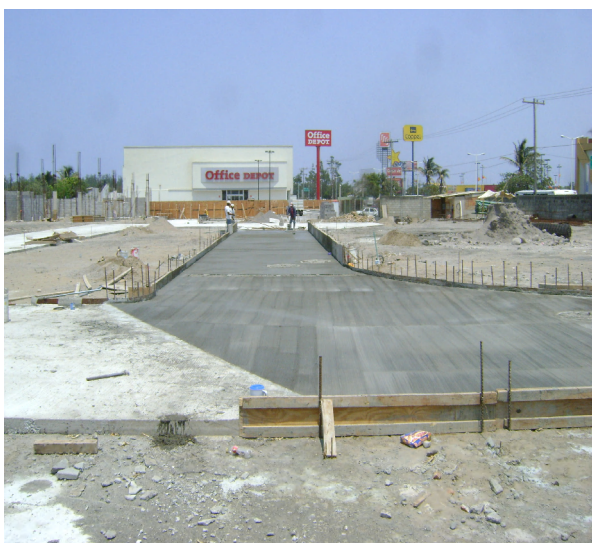
Elaboración de vialidades de áreas exteriores y colocación de adopasto en áreas de cajones de estacionamiento.
