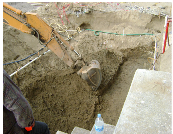
Excavación por medios mecánicos en cisterna en material limo-arenoso.
