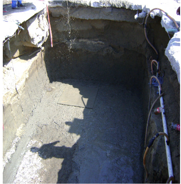
Colocación de plantilla de concreto f'c=100\text{kg/cm}^2 para protección del acero de refuerzo.
