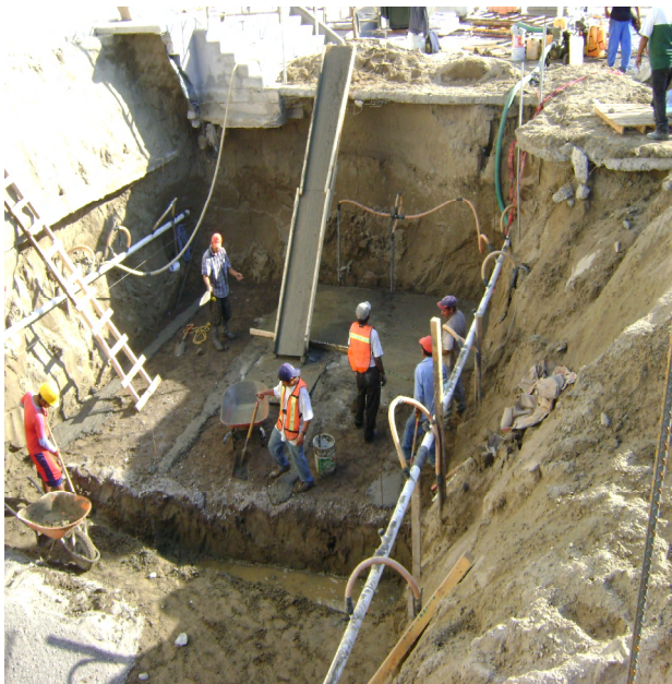
Plantilla de concreto pobre de 7cm de espesor
