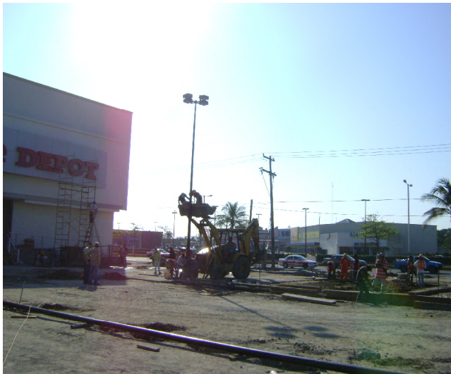
Colocación de postes de alumbrado exterior.
