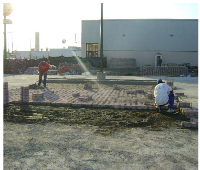
Elaboración de vialidades de áreas exteriores y colocación de adopasto en áreas de cajones de estacionamiento.
