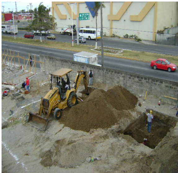
Excavación de zapatas de cimentación con retroexcavadora.
