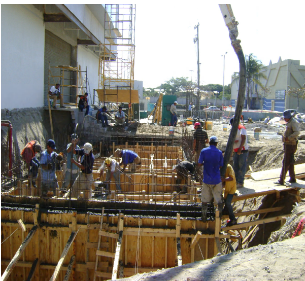
Colado de muros con concreto premezclado.
