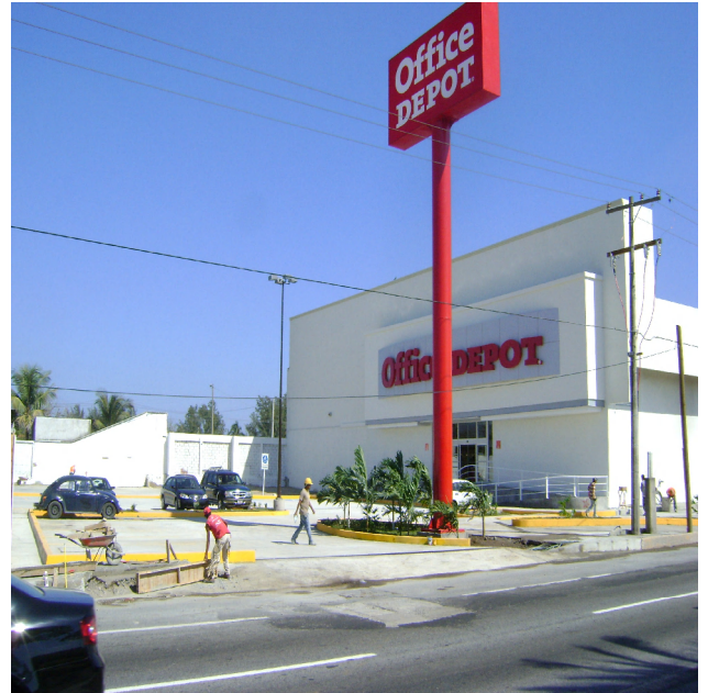
Relleno compactado al 90% Proctor con material producto de excavación y vista de tótem colocado.
