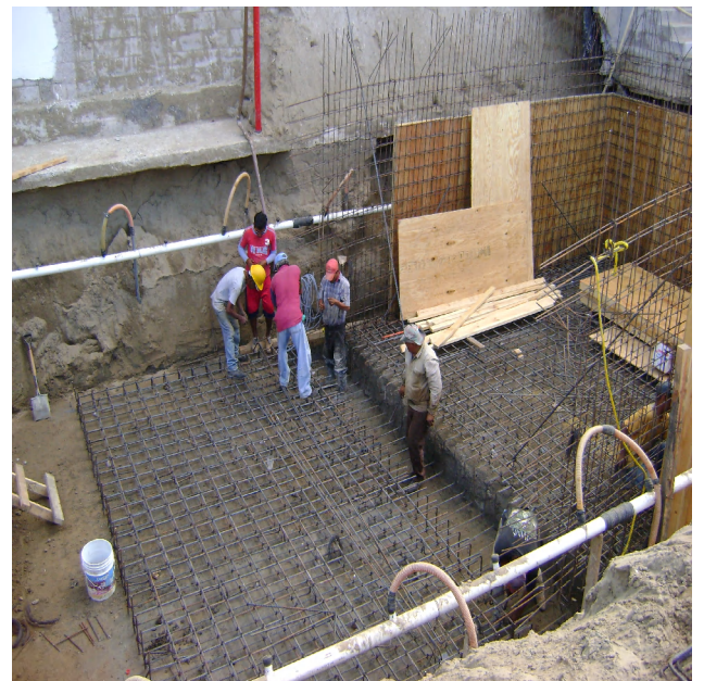
Colocación de acero de refuerzo en losa y muros.
