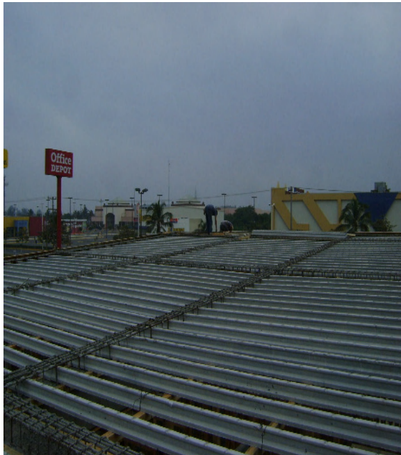
Colocación de vigueta y bovedilla de poliestireno y colado de losa de azotea con concreto bombeado premezclado.
