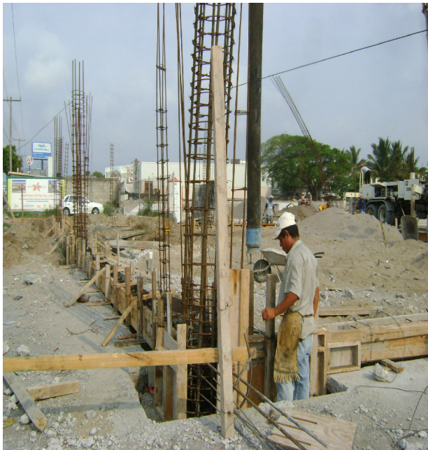
Cimbrado de contratraves de liga del Santander Descimbrado de traves de liga en cimentación, Carl's.
