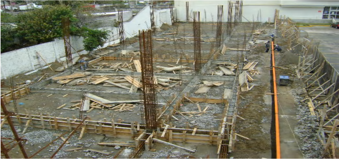
Descimbrado de trabes de cimentación cpo. Der.
