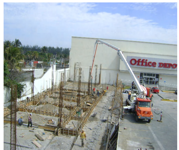
Colado con concreto bombeado premezclado de zapatas de cimentación y traves de liga.
