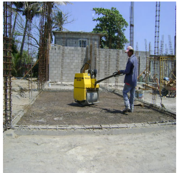
Compactado de rellenos de balastro en cajones de cimentación con rodillo vibratorio.
