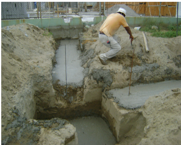
Plantilla para zapata aislada y traveses de cimentación. Zapata de ciment. desplantada a 1.50m del N.P.T.
