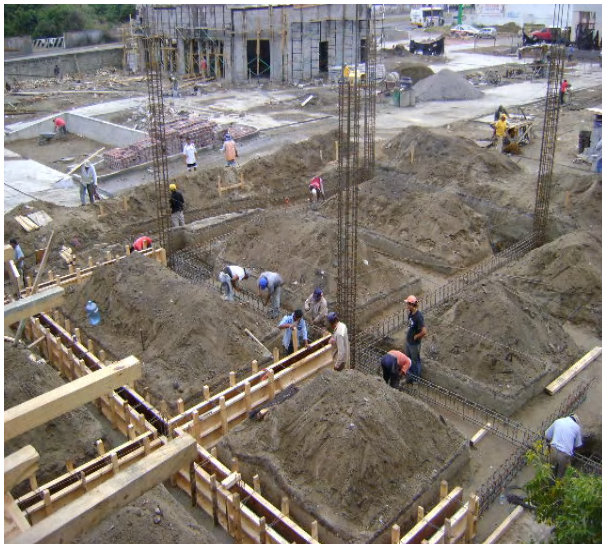
Armado de traves de cimentación, cpo. Central.
