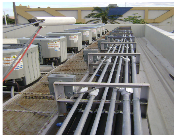
Instalación de equipos de aire acondicionado e inst. especiales en losa de azotea, Banco Santander.
