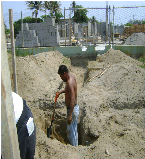
Excavación de zapatas de cimentación, del Santander
