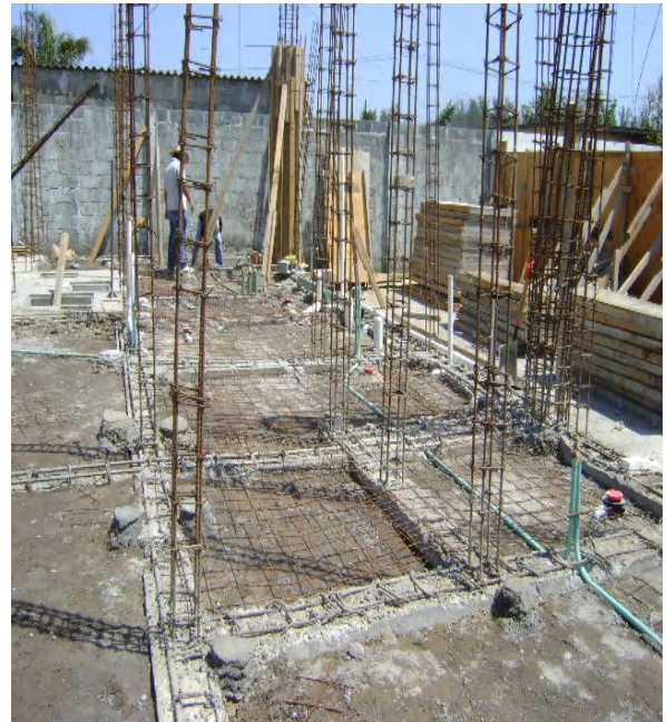
Las instalaciones sanitarias y eléctricas ahogadas en cimentación.
