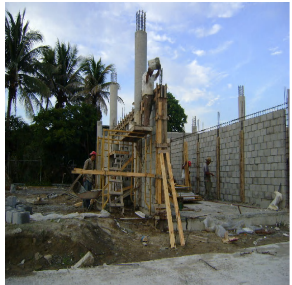
Colado de castillos y traves de cerramiento.
