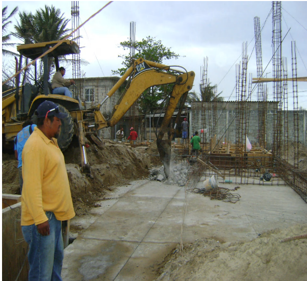
Demolición de losa de piso existente de 20 cm de esp.
