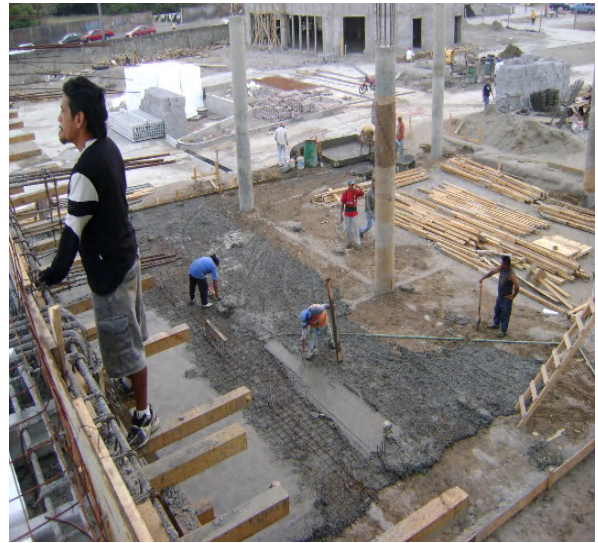
Colado de pisos con concreto premezclados de los cuerpos central y cuerpo izquierdo.
