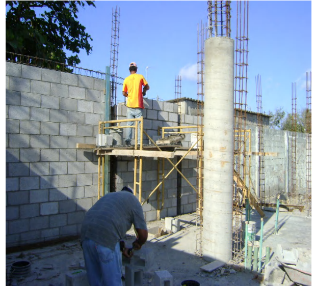
Desplante de muros de block hueco 15x20x40 cm. con ref. horizontal, de colindancia y divisorios.
