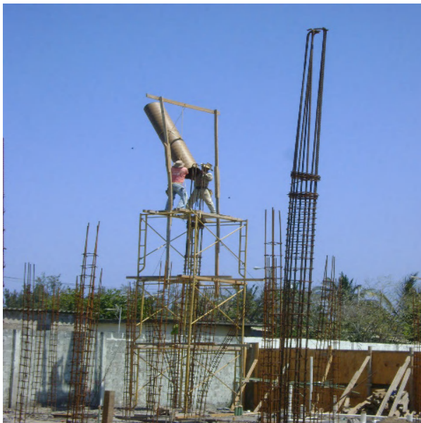
Colocación de sonotubo de 50 cm. de diámetro, cimbrado y colado de columnas.
