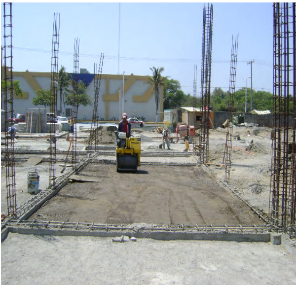
Compactado de rellenos de balastro en cajones de cimentación con rodillo vibratorio.
