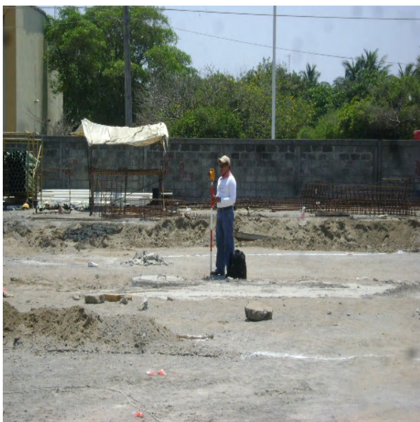
Marcado de puntos en terreno.
