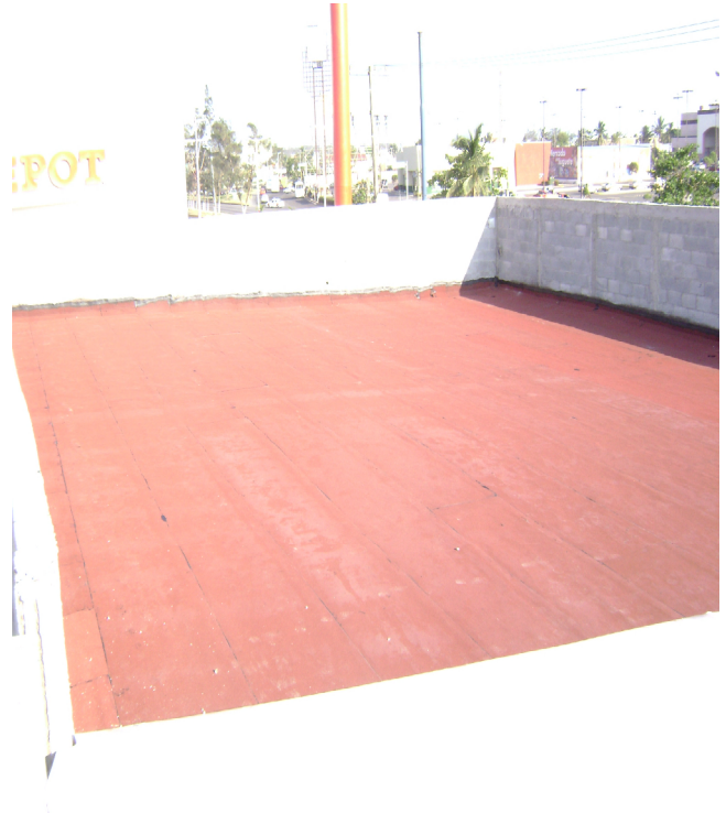
Impermeabilización de azotea, con prefabricado y color terracota.
