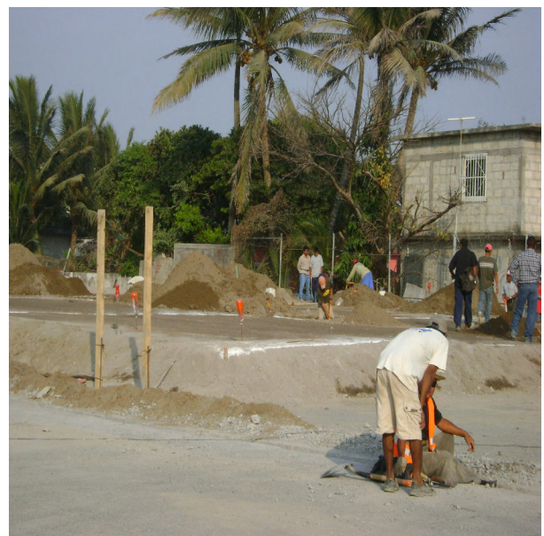
Trazado de ejes con cal en cimentación.
