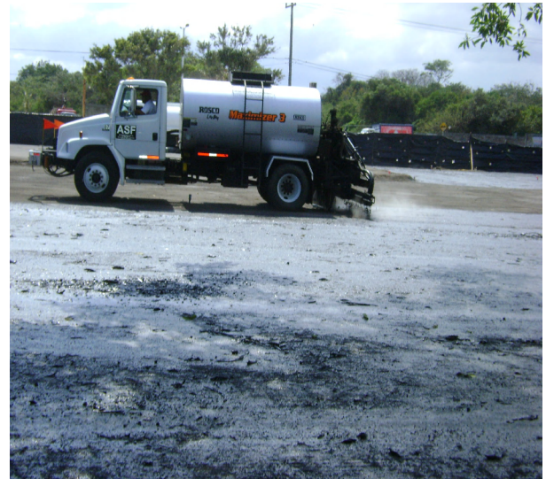
Aplicación de riego de impregnación a plataformas.
