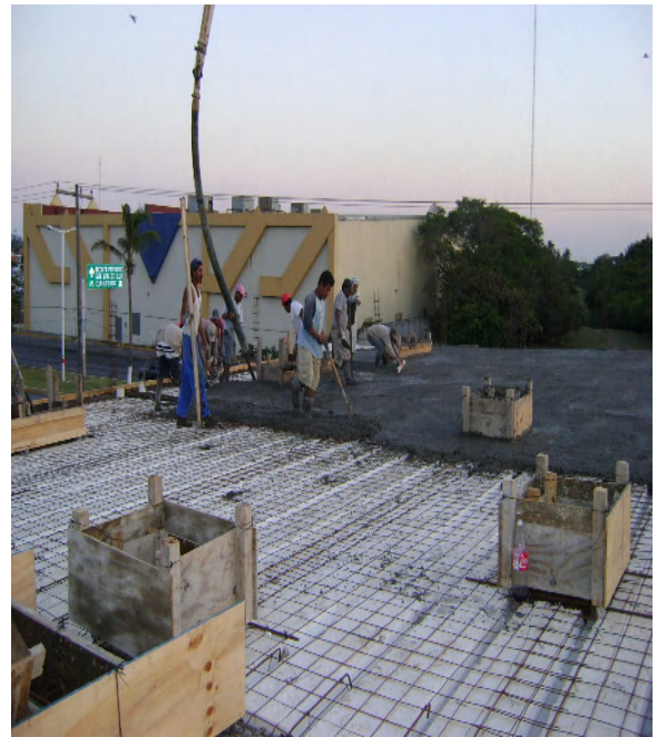
Colocación de Viguetas y colado de losa de azotea, Carl's Junior.
