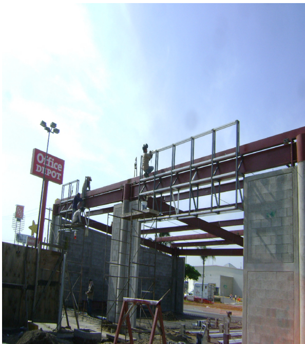
Armado de estructura de faldón y colocación de losa multytecho, Banco Santander.
