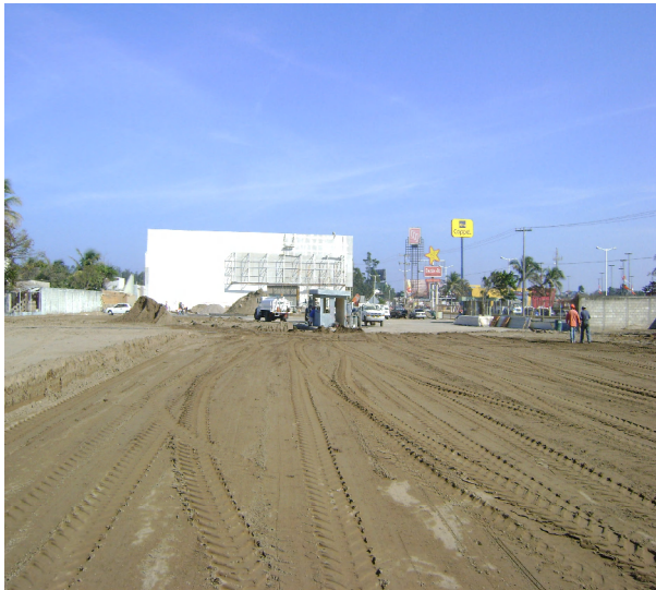
Nivelación y compactación de plataformas.
