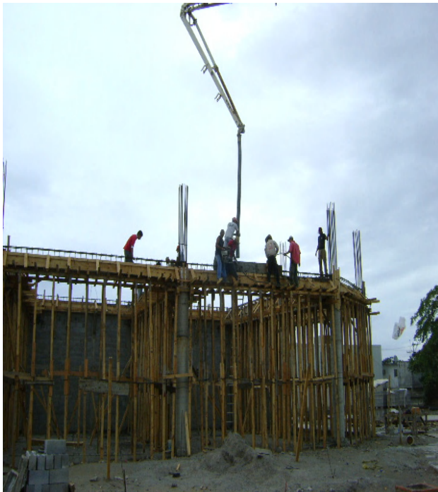
Cimbrado, armado y colado de trabes de concreto en losa, y desplante de muros de P.B. de local Carl's Junior.
