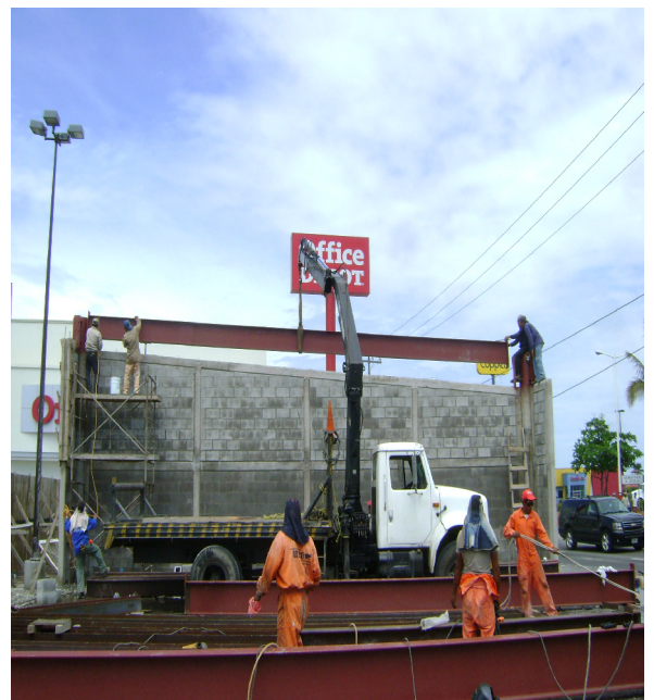
Desplante de muros de block, colado de cadena de cerramiento y montaje de vigas de acero tipo I, en Banco Santander.
