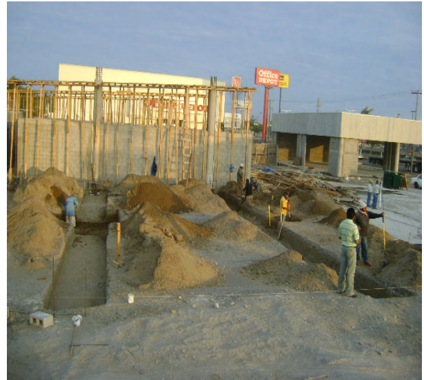
Excavación de cepa en material tipo I a mano.
