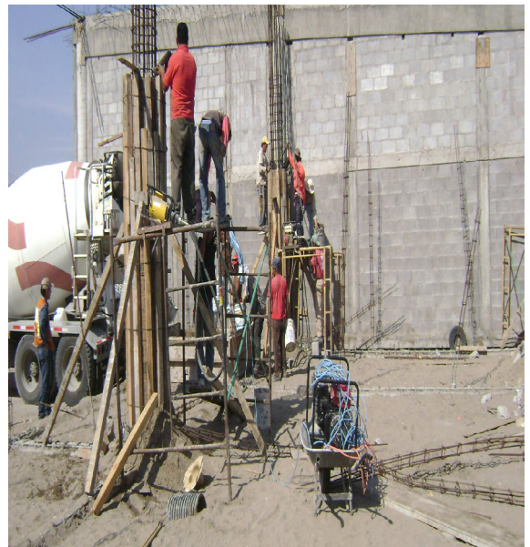
Colocación de sonotubo de 50 cm. de diámetro, cimbrado y colado de columnas.
