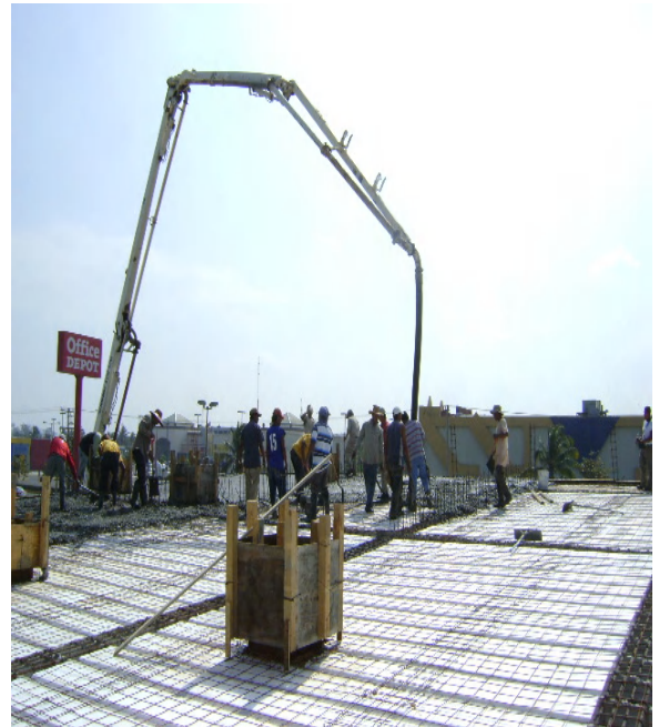
Colocación de vigueta y bovedilla de poliestireno y colado de losa de azotea con concreto bombeado premezclado.
