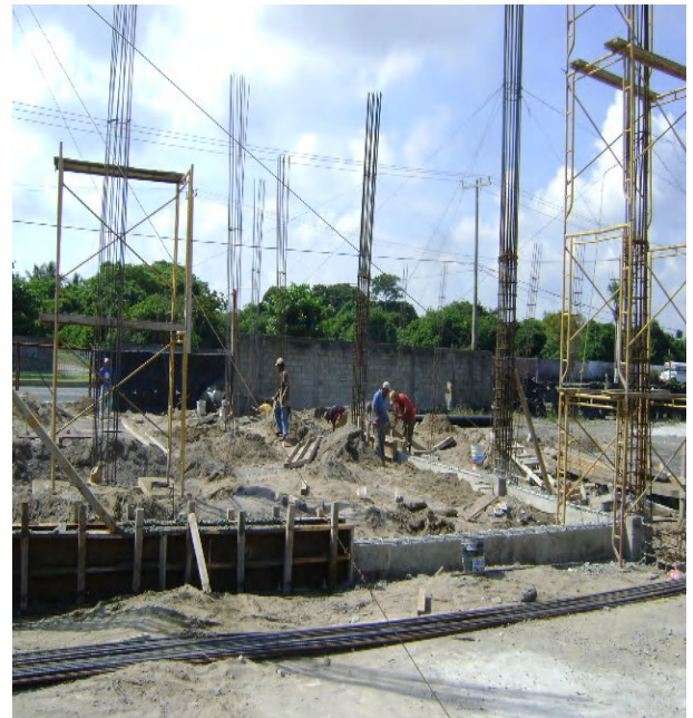
Cimbrado de contratraves de liga del Santander Descimbrado de traves de liga en cimentación, Carl's.
