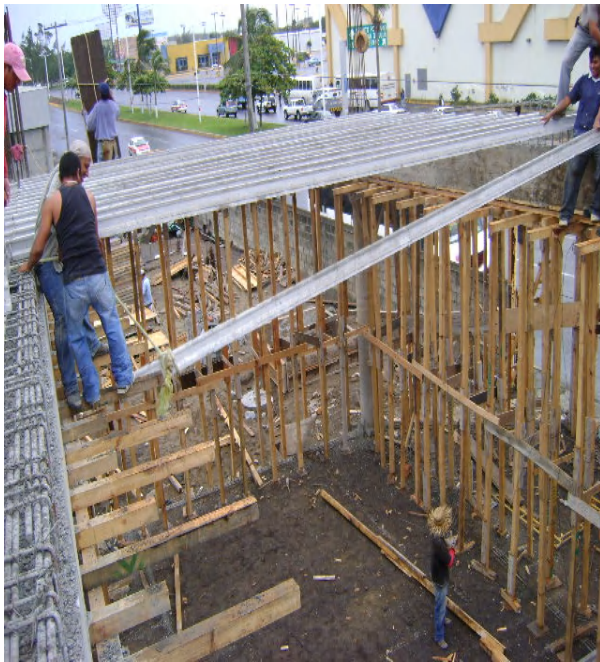
Colocación de Viguetas y colado de losa de azotea, Carl's Junior.
