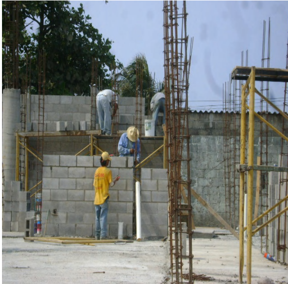
Desplante de muros de block hueco 15x20x40 cm. con ref. horizontal, de colindancia y divisorios.
