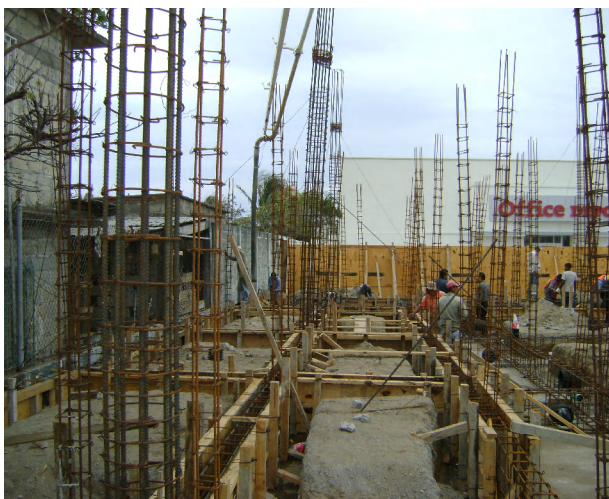
Colado con concreto bombeado premezclado de zapatas de cimentación y traves de liga.
