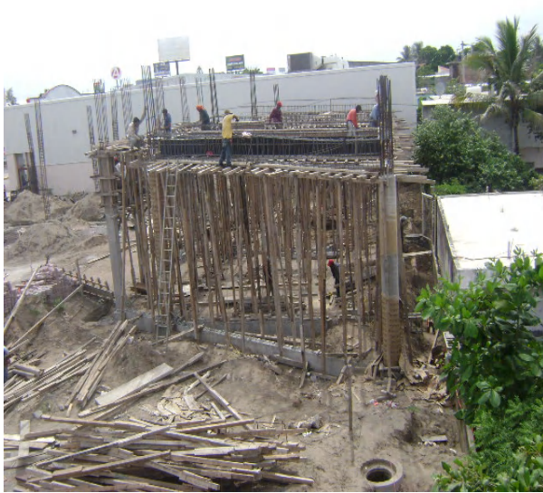
Cimbrado y armado de traves de losa azotea, cuerpos izquierdo y derecho.
