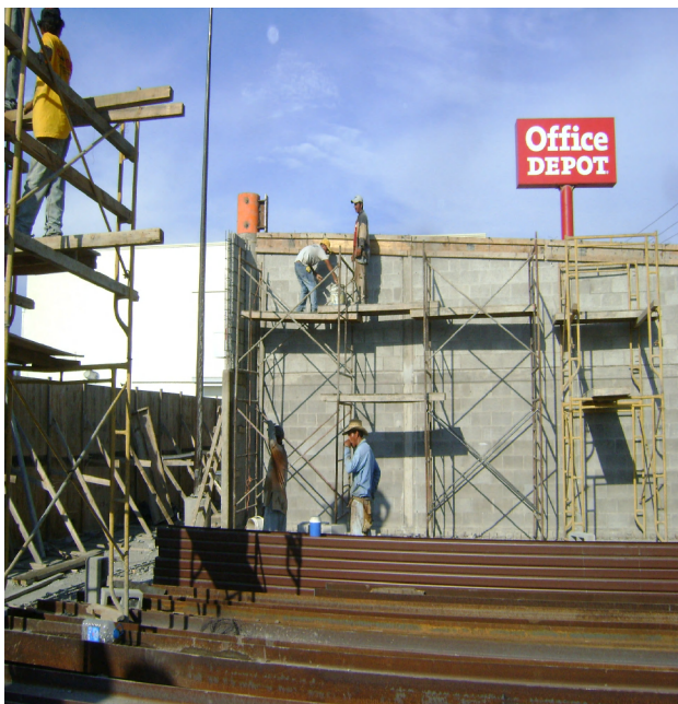
Desplante de muros de block, colado de cadena de cerramiento y montaje de vigas de acero tipo I, en Banco Santander.
