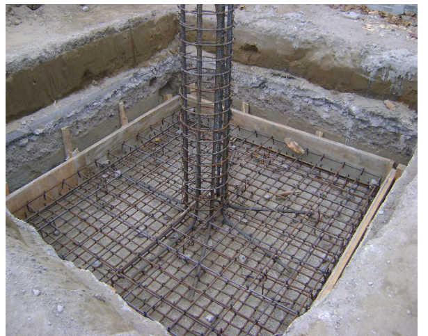
Plantilla para zapata aislada y traveses de cimentación. Zapata de ciment. desplantada a 1.50m del N.P.T.
