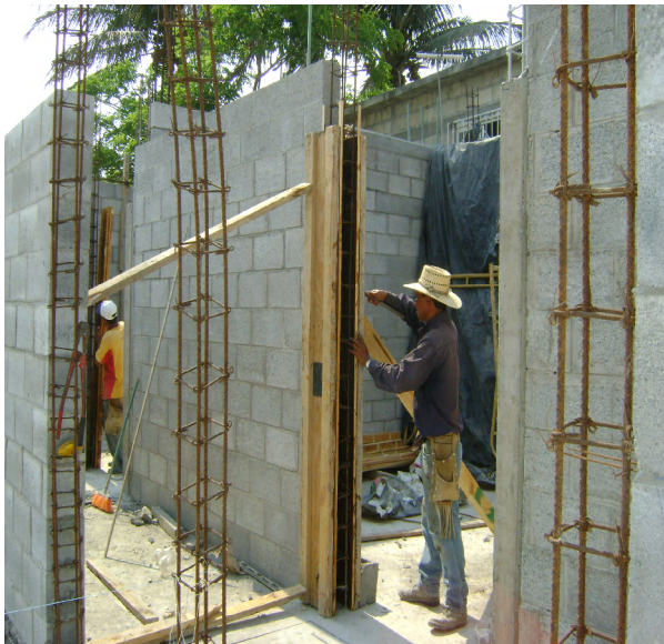
Cimbrado de castillos con cimbra aparente.
