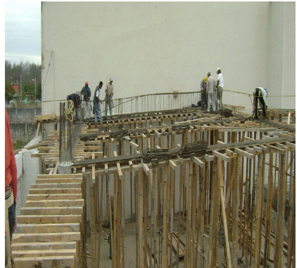
Cimbrado y armado de traves de losa azotea, cuerpos izquierdo y derecho.
