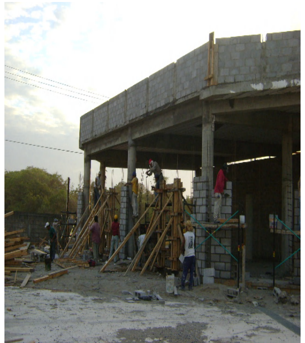
Cimbrado, armado y colado de trabes de concreto en losa, y desplante de muros de P.B. de local Carl's Junior.
