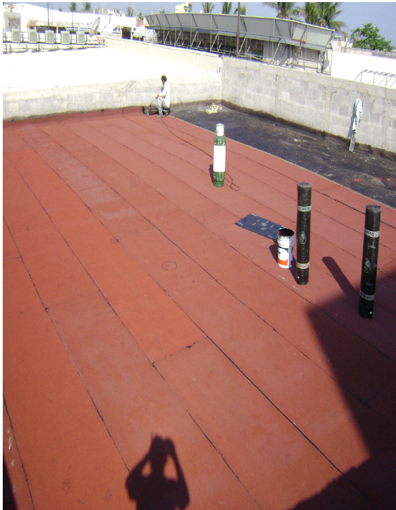
Impermeabilización de azotea, con prefabricado y color terracota.
