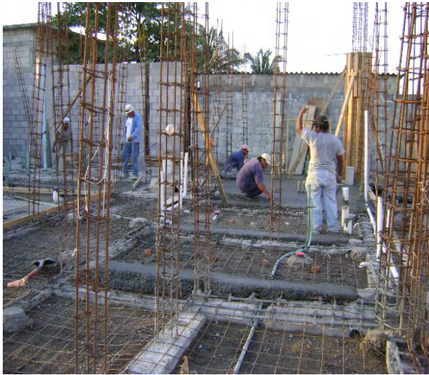
Colado de pisos con concreto premezclados de los cuerpos central y cuerpo izquierdo.
