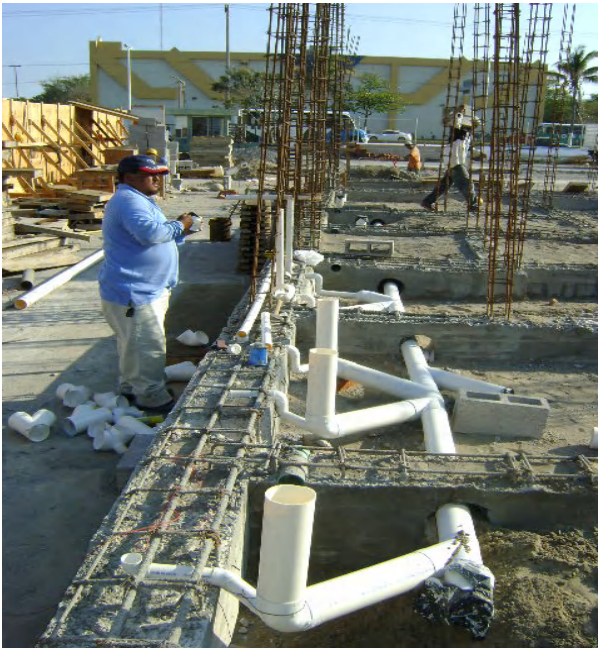
Las instalaciones sanitarias y eléctricas ahogadas en cimentación.
