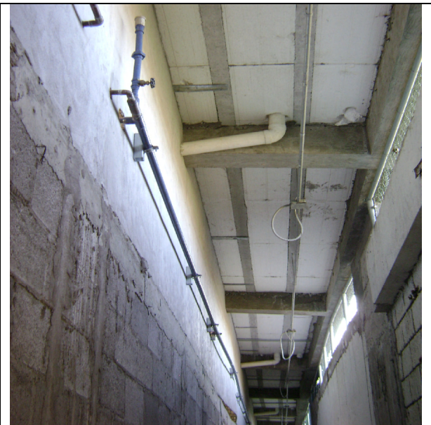
Instalaciones sanitaria, hidráulica y eléctrica visibles por pasillos.
