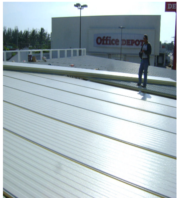
Armado de estructura de faldón y colocación de losa multytecho, Banco Santander.
