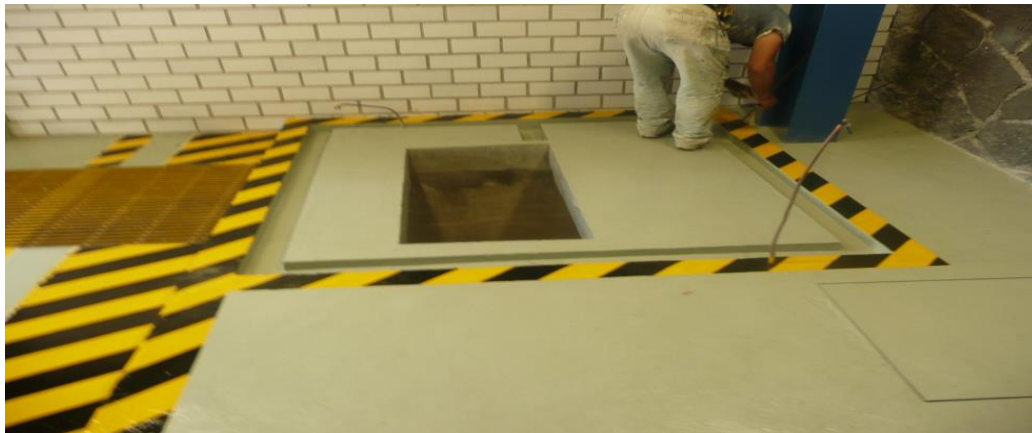
Figura 3.29. Piso de una subestación
