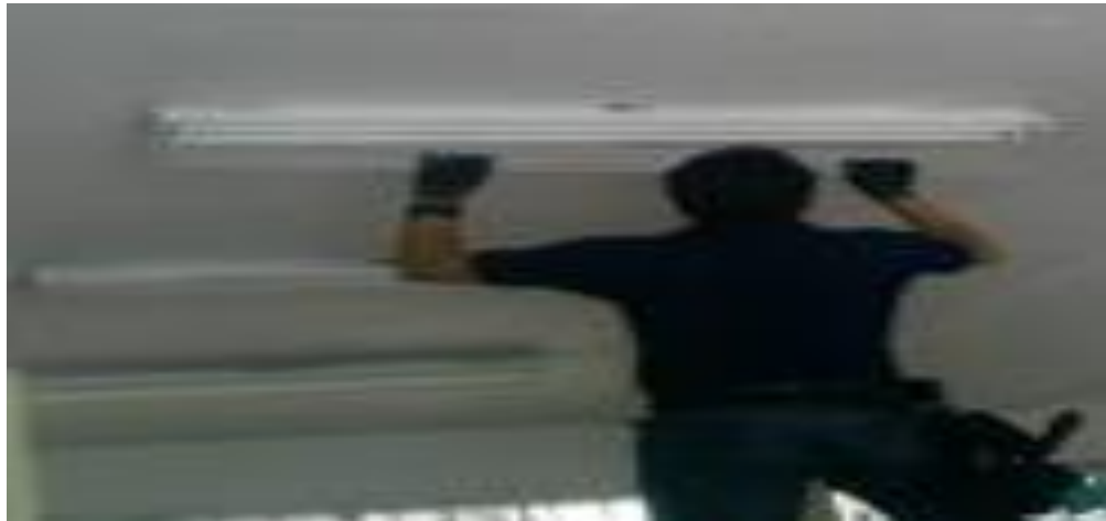
Figura 3.27. Mantenimiento a Luminarias.
