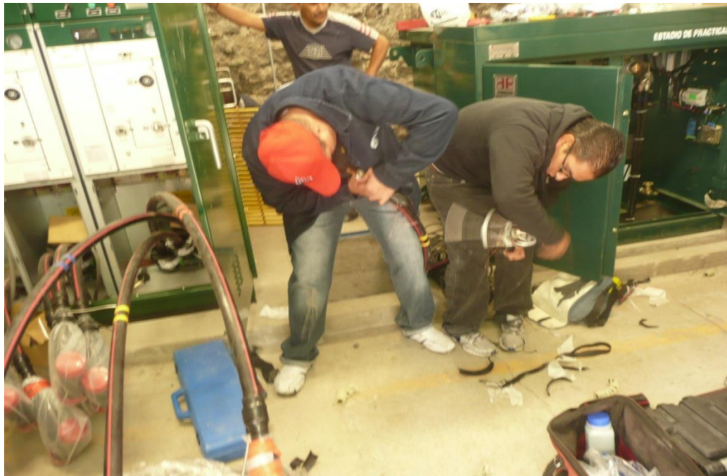
Figura 3.7. Espacio de trabajo
