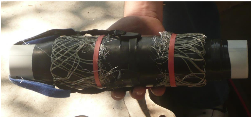
Figura.3.14. Empalme utilizado en el Anillo B.
