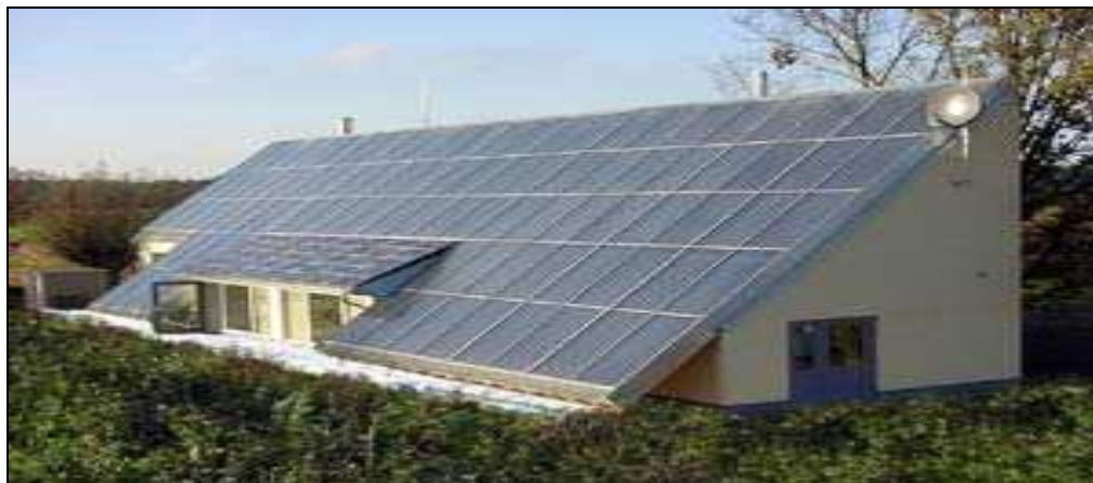
CASA PROTOTIPO CON EL MÁXIMO ESPACIO PARA LA CAPTACIÓN DE ENERGÍA SOLAR, ESPAÑA
