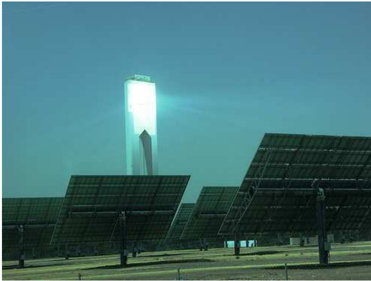
Figura F. Centrales de Torre.
