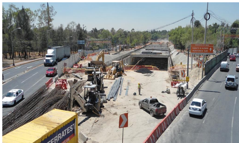
Figura 4.4 Vista de los trabajos realizados en el tramo II Palmas-Alencastre
